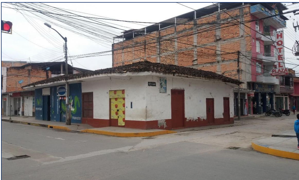
Anexo 3G: Vivienda con material de construcción de tapia, ubicada en el Jr. San Martín con Jr. Serafín Filomeno, es estado de conservación malo. Centro de la ciudad de Moyobamba. - Barrio de Belén
