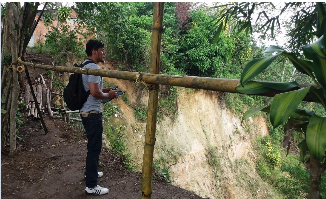
Anexo 6G: Levantamiento de puntos GPS, del Barranco Tumino. Zona de deslizamiento.
