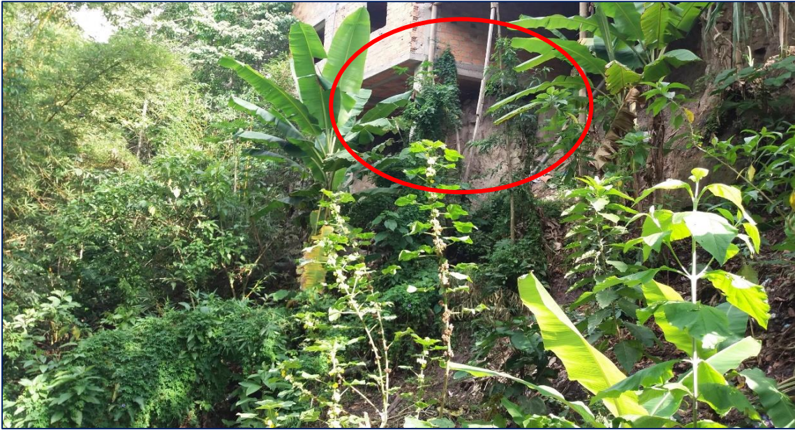
Anexo 5G: Viviendas ubicadas en el sector Punta de Doñe – Barranco Tumino. Construidas con material de ladrillo /bloque de cemento en la ladera del barranco, alta vulnerabilidad. Barrio de Calvario.
