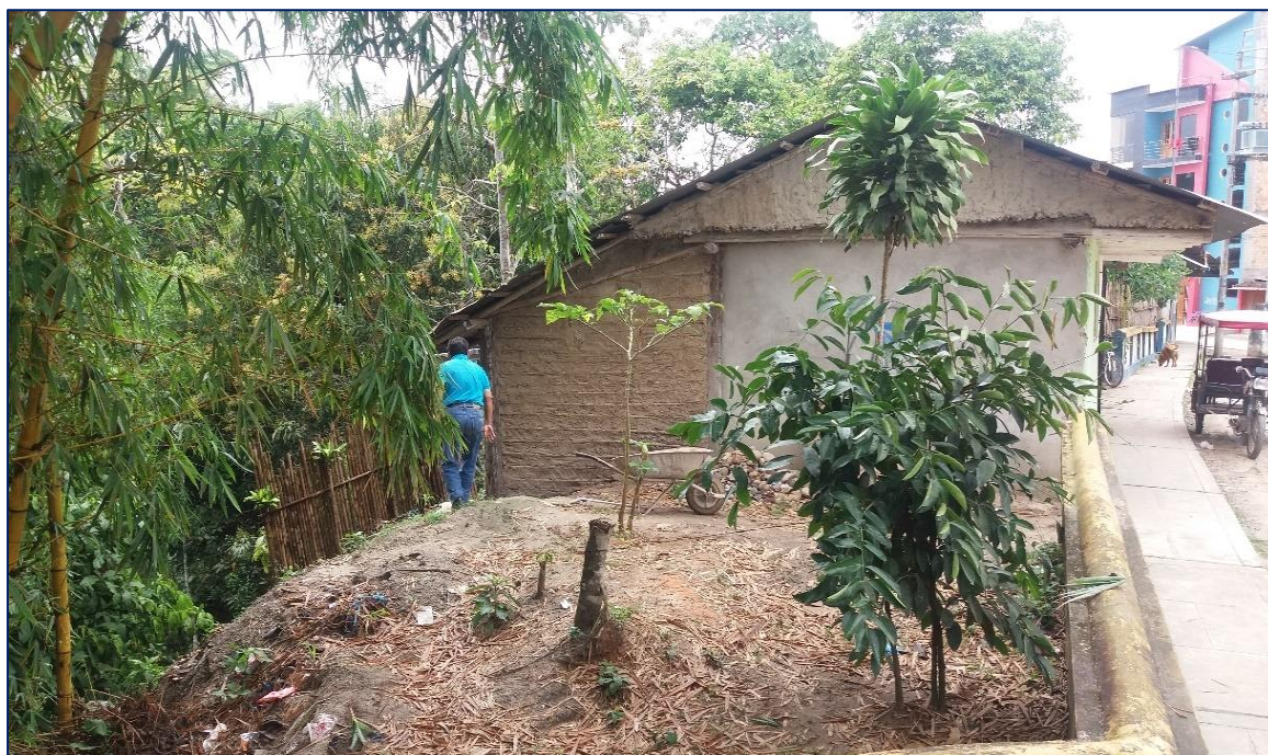
Anexo 1G: Vivienda con material de construcción de quincha, ubicada en la ladera del barranco Fachin Barrio de Lluyllucucha.
