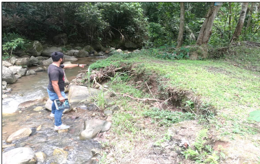
Fotografía 4. Ensanchamiento de la quebrada
