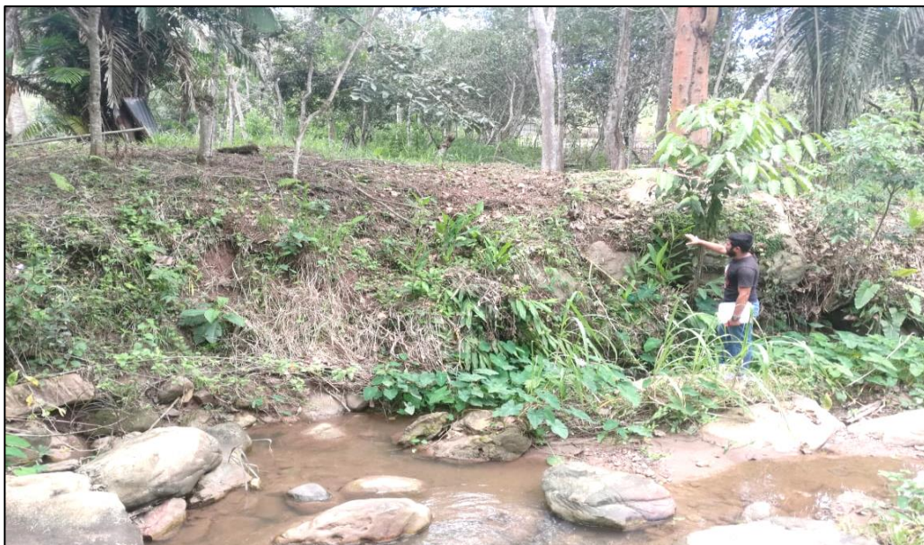
Fotografía 3. Derrumbes y desbordes de la quebrada
