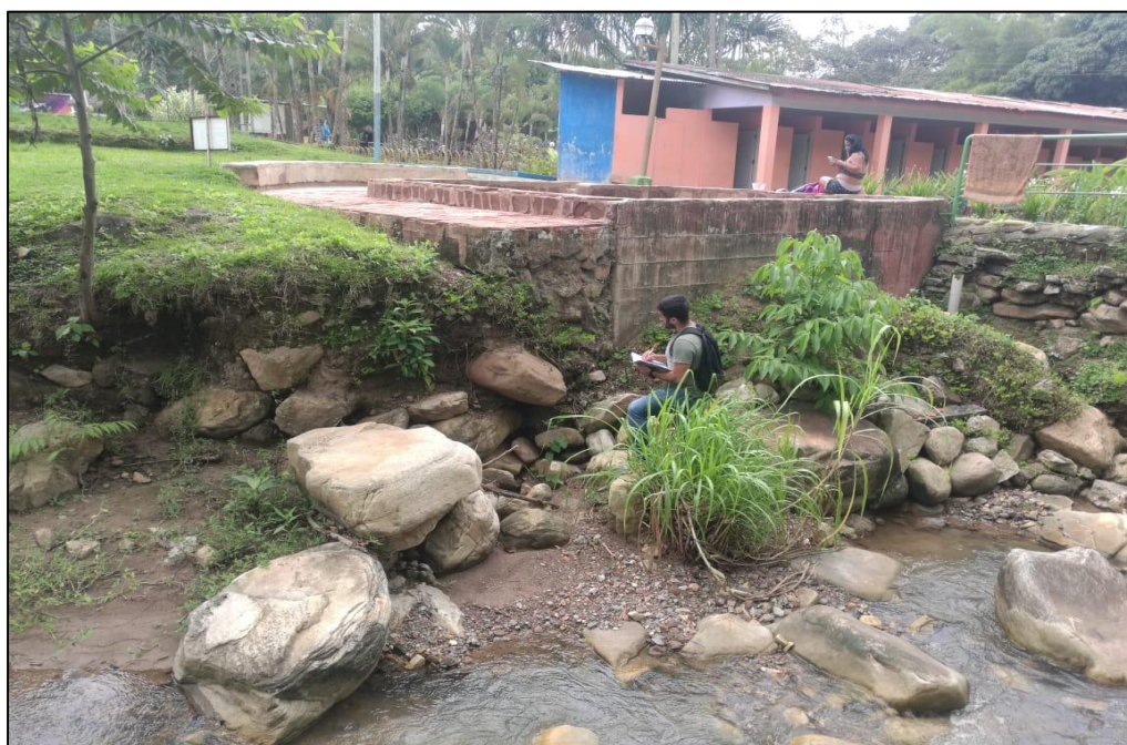
Fotografía 5. Estructura de las piscinas
