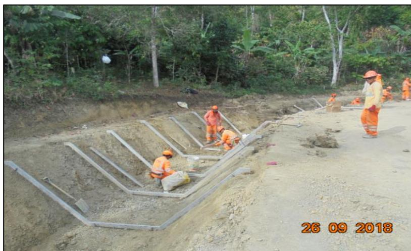
**Figura 19.** Encofrado de Caja de Canal Trapezoidal. (Fuente: Propia)
