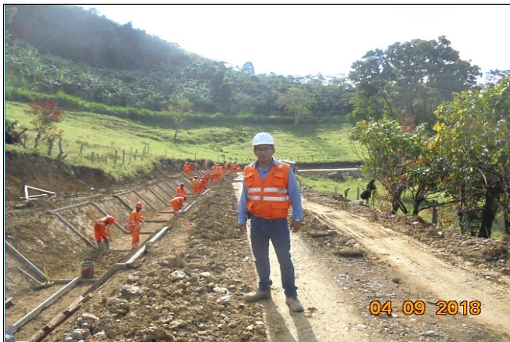
**Foto 3.** Se realiza Trabajos de Refine, Nivelación y Compactación en Canal Tipo Trapezoidal
