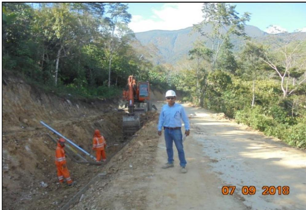
**Foto 7.** Se Realizan Excavación de Caja de Canal con Excavadora Neumática en la construcción de Canal Tipo Trapezoidal
