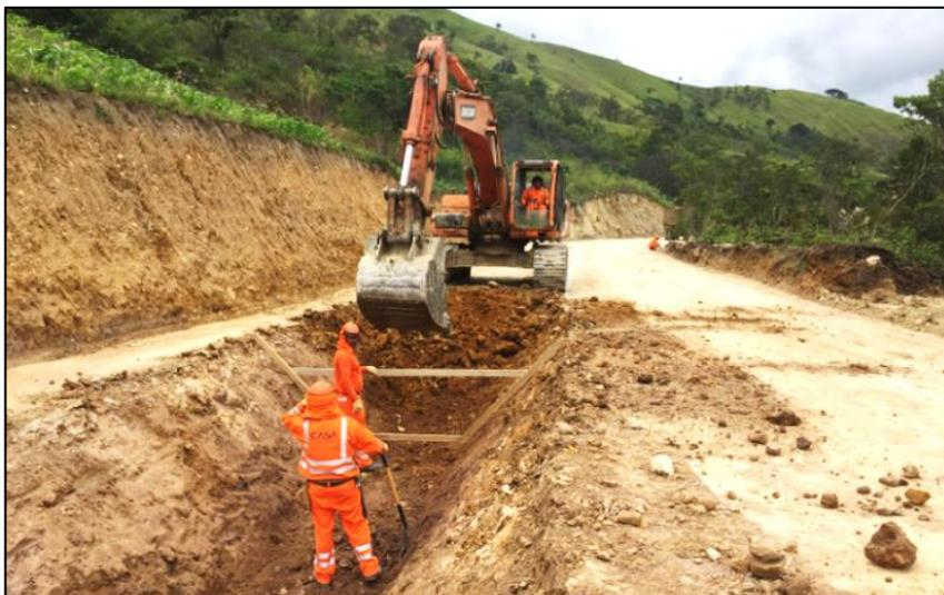
***Figura 18.*** Excavación de caja de Canal Trapezoidal. (Fuente: Propia)
