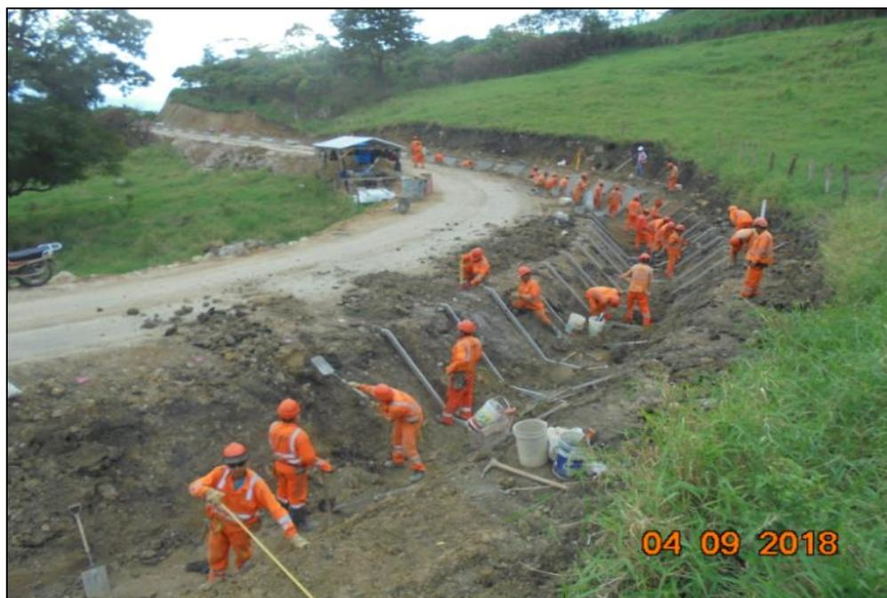
*Foto5.* Se Realizan Trabajos de Encofrado, Refine, Nivelación y Compactación en Canal Tipo Trapezoidal
