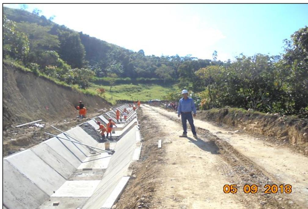
**Foto 4.** Revestimiento de Concreto  $f'c=175 \text{ kg/cm}^2$   $e=0.075\text{m}$  de paños alternos en Canal Tipo Trapezoidal
