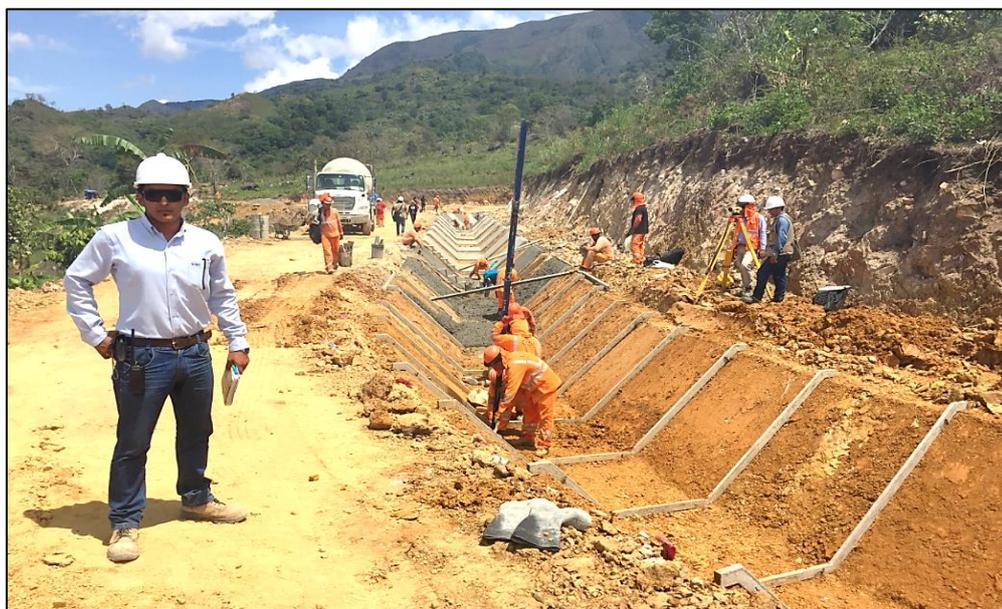
**Foto 12.** Revestimiento de Concreto  $f'c=175 \text{ kg/cm}^2$   $e=0.075\text{m}$  en la construcción de Canal Tipo Trapezoidal
