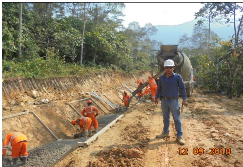
**Foto 9.** Revestimiento de Concreto  $f'c=175 \text{ kg/cm}^2$   $e=0.075\text{m}$  en la construcción de Canal Tipo Trapezoidal
