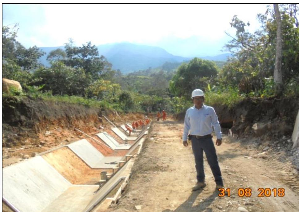
**Foto 2.** Preparación de paños alternados para Revestimiento de Concreto  $f'c=175 \text{ kg/cm}^2$   $e=0.075\text{m}$  en Canal Tipo Trapezoidal
