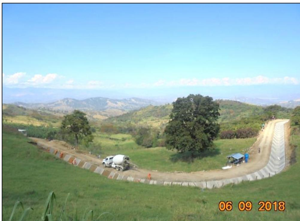
*Foto 6.* Panorámica de la construcción de Canal Tipo Trapezoidal
