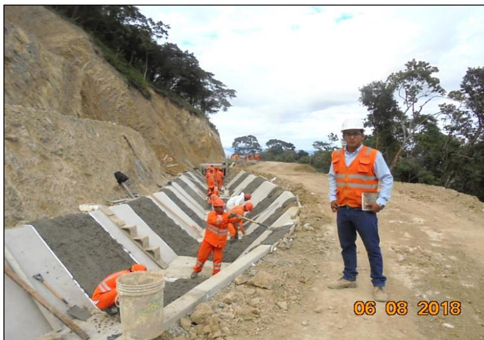
**Foto 1.** Revestimiento de Concreto  $f'c=175 \text{ kg/cm}^2$   $e=0.075\text{m}$  en Canal Tipo Trapezoidal
