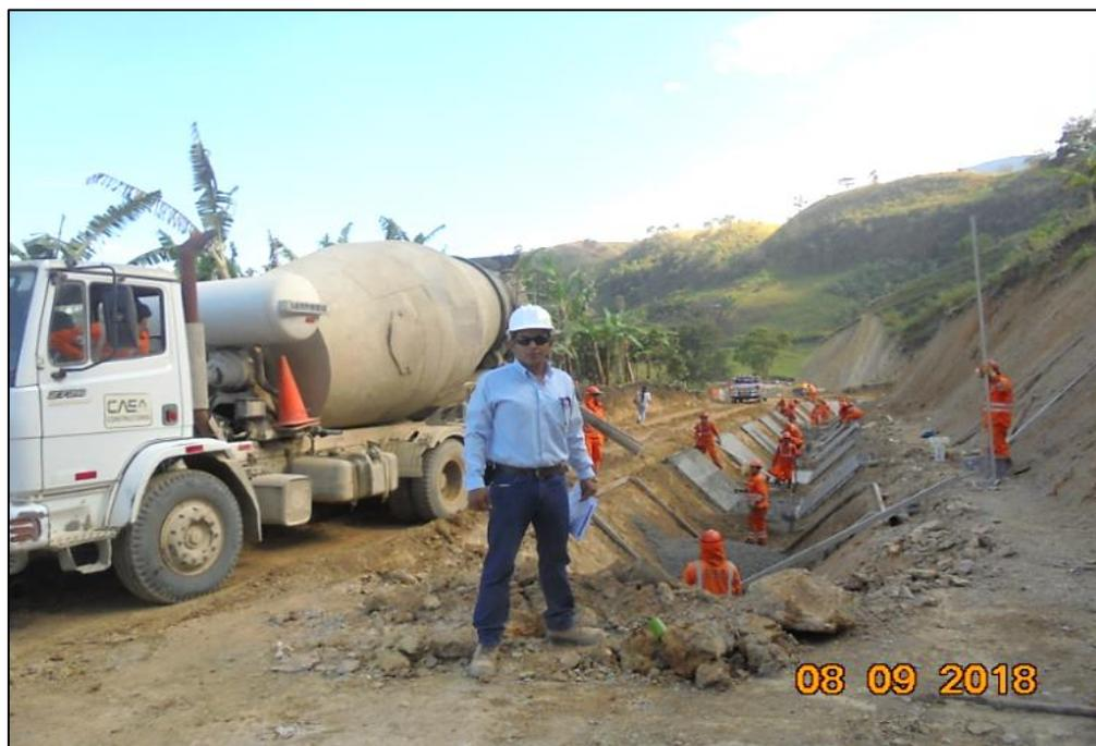
**Foto 8.** Revestimiento de Concreto  $f'c=175 \text{ kg/cm}^2$   $e=0.075\text{m}$  en la construcción de Canal Tipo Trapezoidal
