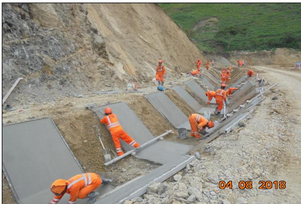
**Figura 21.** Revestimiento de Concret en Caja de Canal Trapezoidal.
