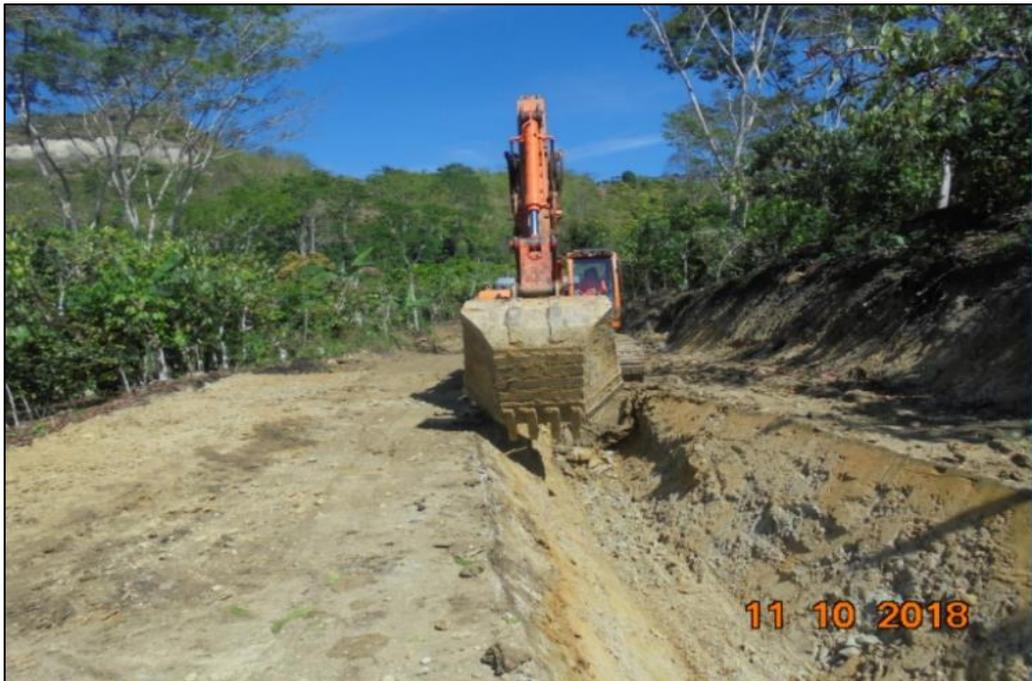
**Foto 11.** Excavación de Caja de Canal en la construcción de Canal Tipo Trapezoidal
