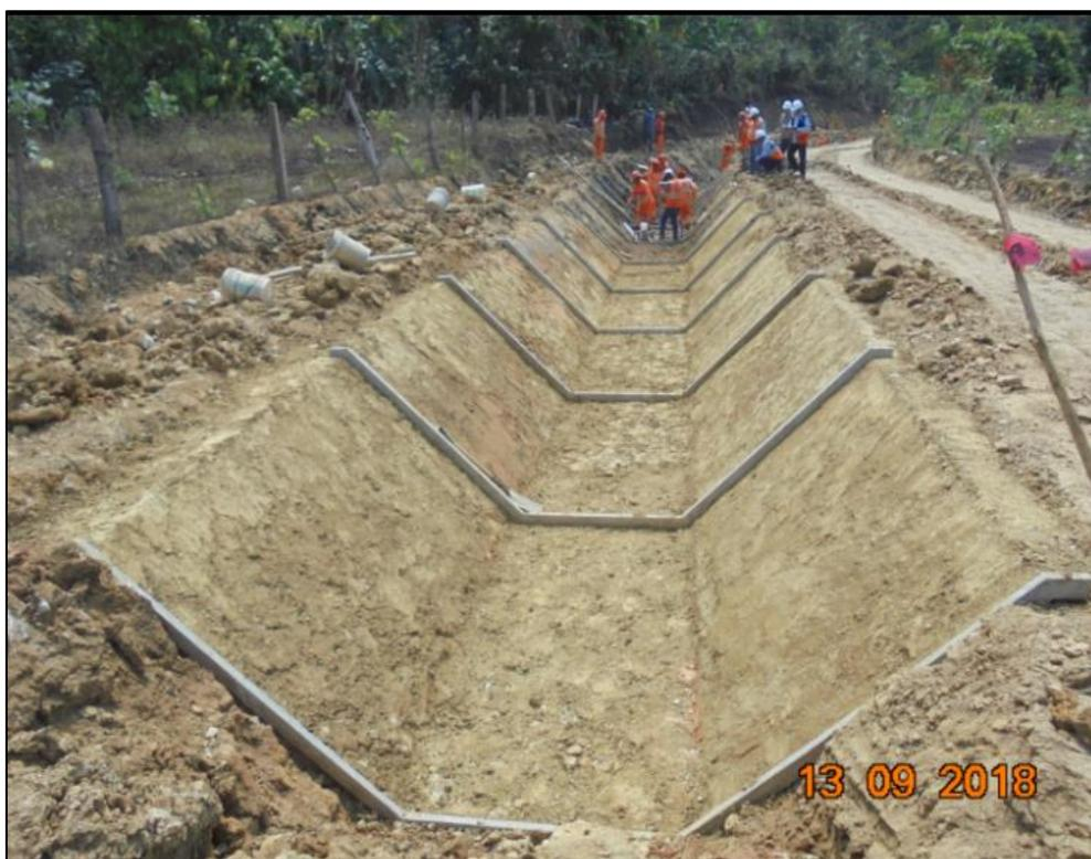
**Foto 10.** Refine, Nivelación y Compactación en la construcción de Canal Tipo Trapezoidal
