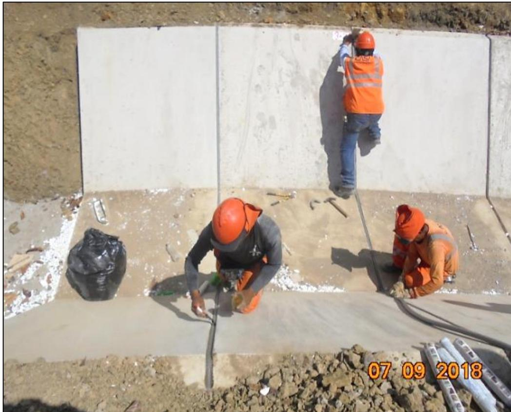
**Foto 13.** Sellado de Junta elastomérica  $e=0.025\text{m}$  en la construcción de Canal Tipo Trapezoidal
