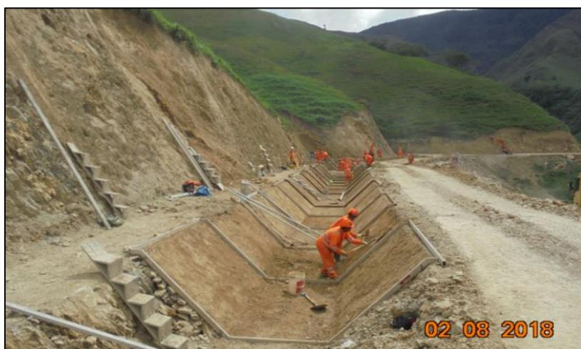
**Figura 20.** Refine Nivelación y Compactación en Caja de Canal Trapezoidal (Fuente: Propia)
