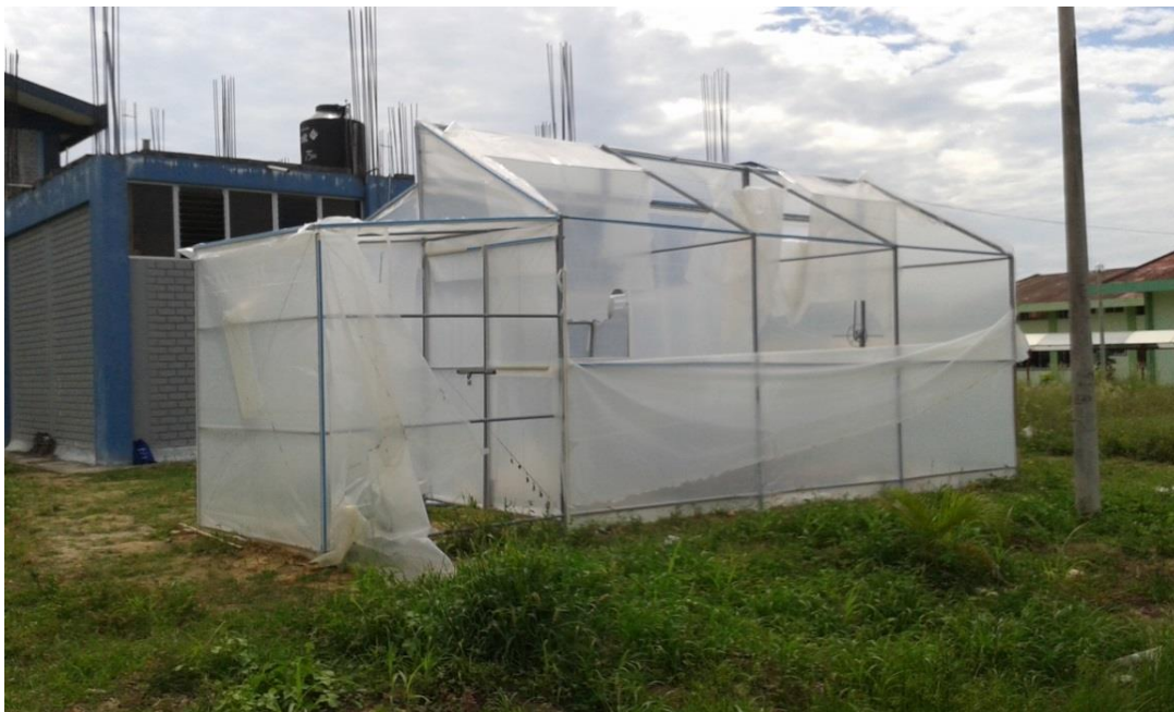
Figura 15.- Cobertura de plástico deteriorada por el Clima
