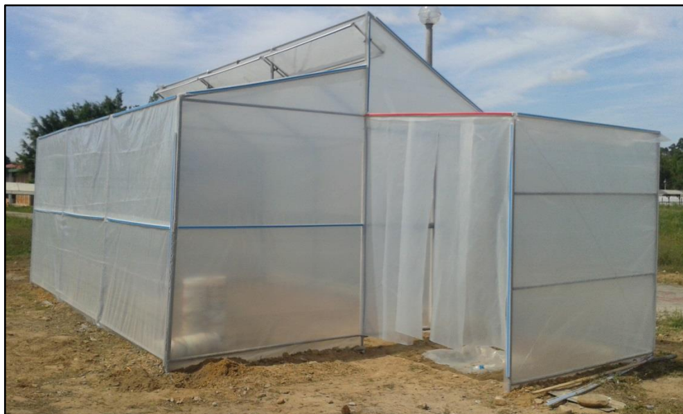
Figura 14.- Estructura del Invernadero con cobertura de Polietileno
