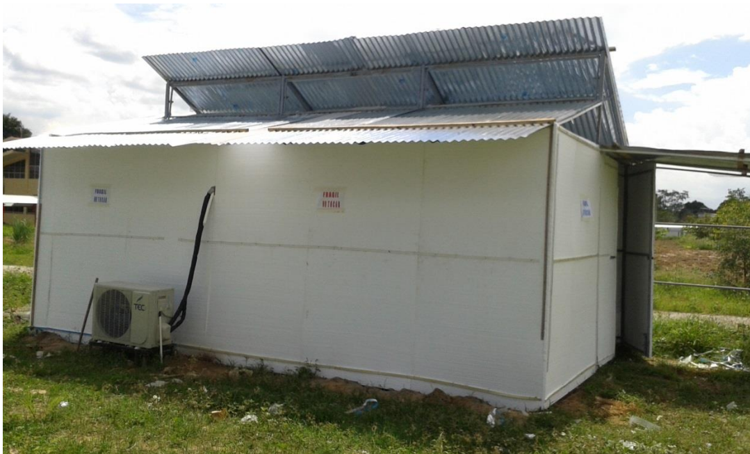
Figura 16.- Estructura metálica con cobertura de Tecnopor y calamina.
