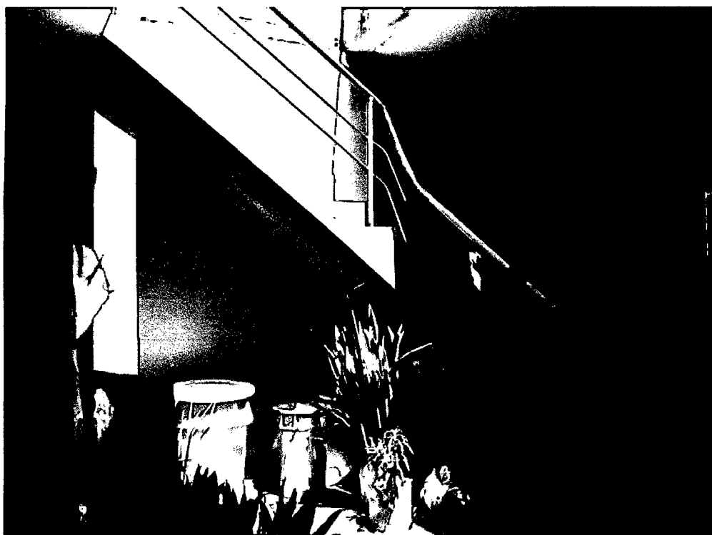
ESCALERA DE ACCESO AL PISO 2
