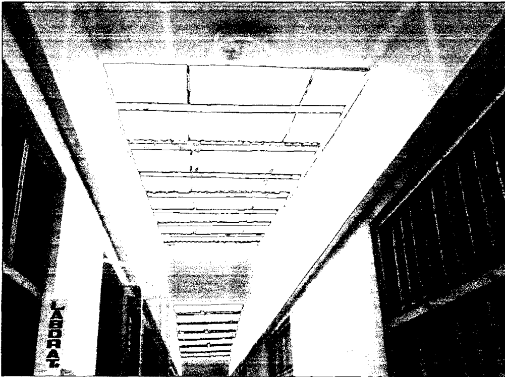
VISTA INTERIOR DE LA COBERTURA DEL TECHO DEL PISO 2
