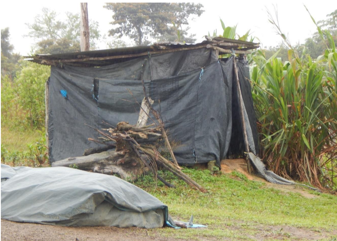
Fotografía 4. Letrina artesanal con caseta cubierta con mantas.
