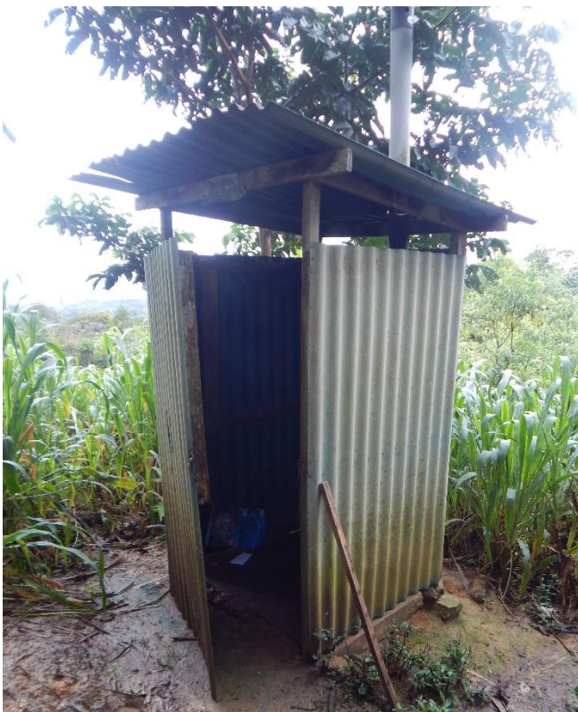
Fotografía 5. Letrina de hoyo seco ventilado.
