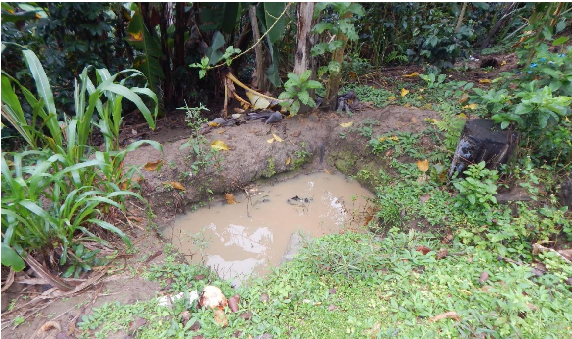
Fotografía 15. Poso de infiltración de aguas grises.
