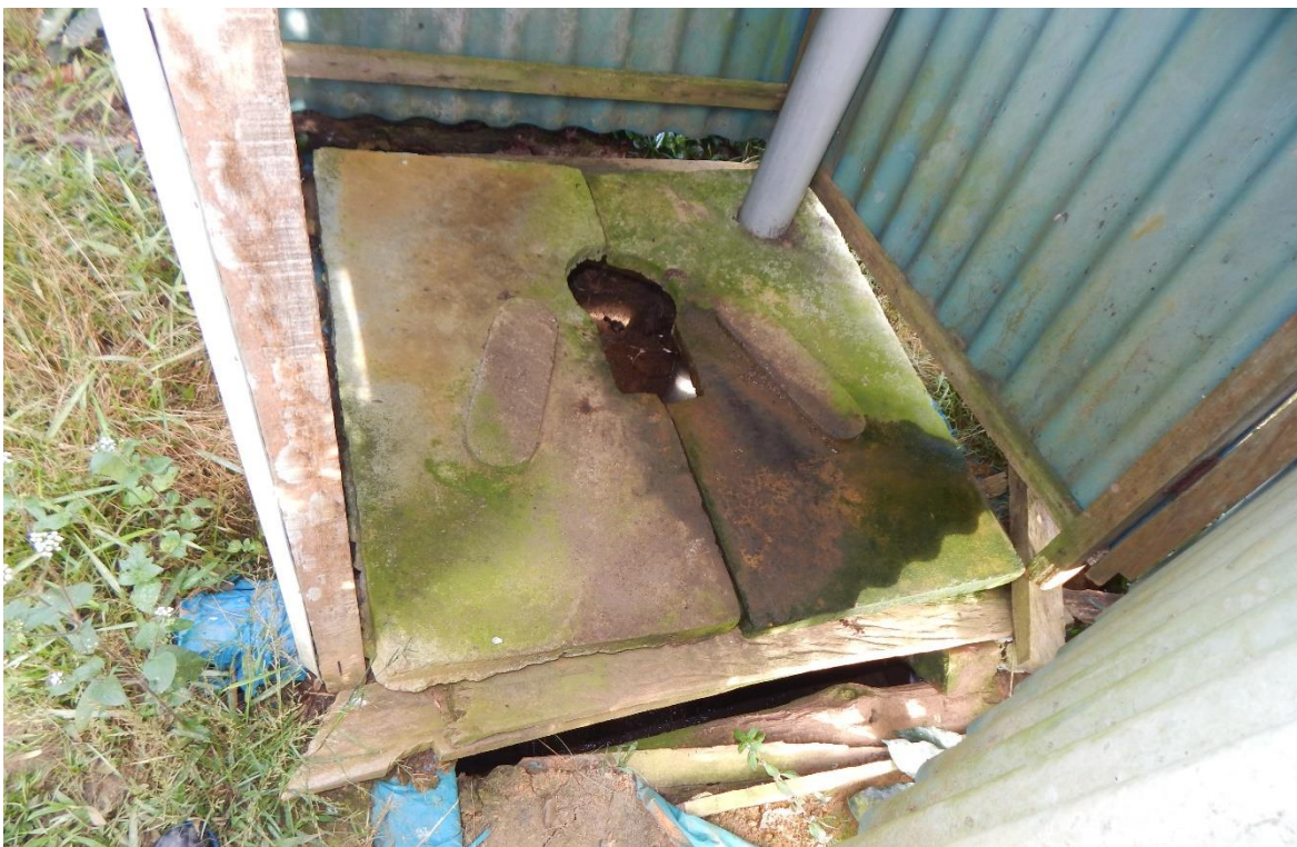
Fotografía 8. Letrina de hoyo seco de condición regular.
