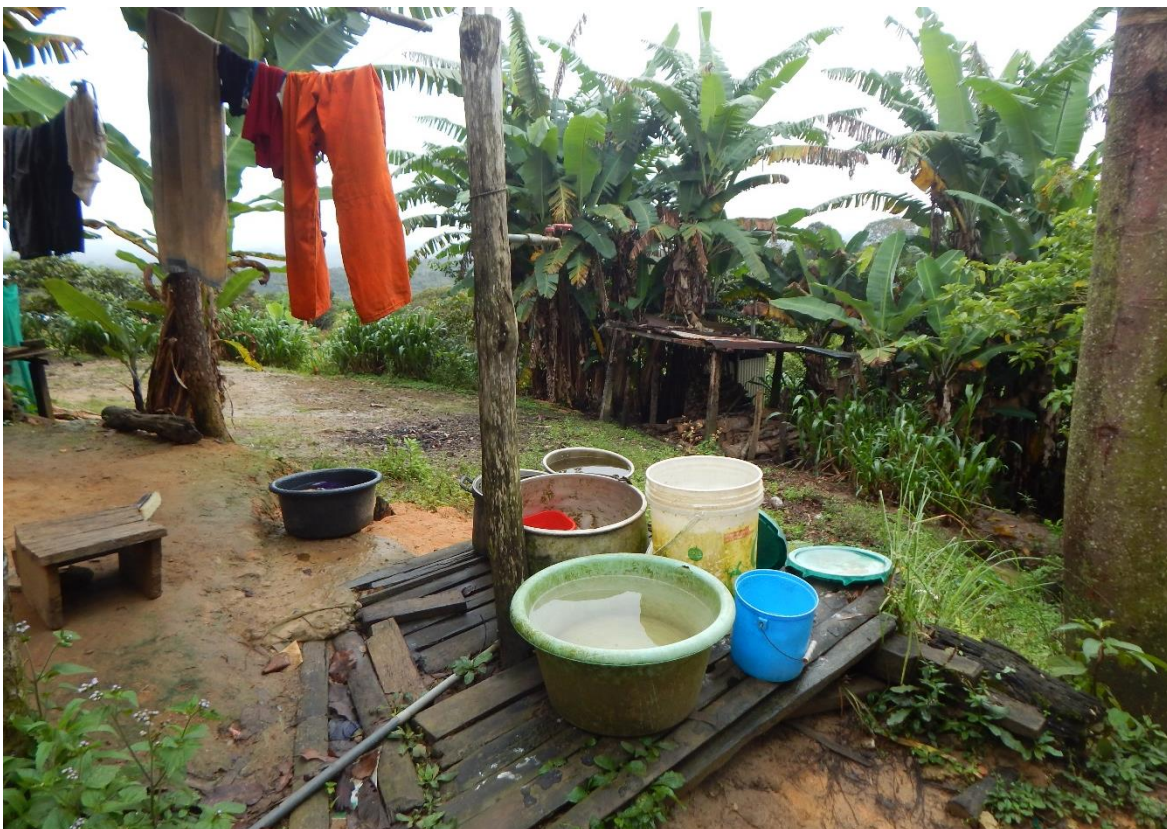
Fotografía 12. Conexión domiciliaria y depósitos de almacén de agua.
