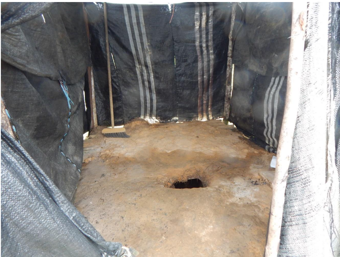
Fotografía 7. Letrina de hoyo seco de condición bueno.
