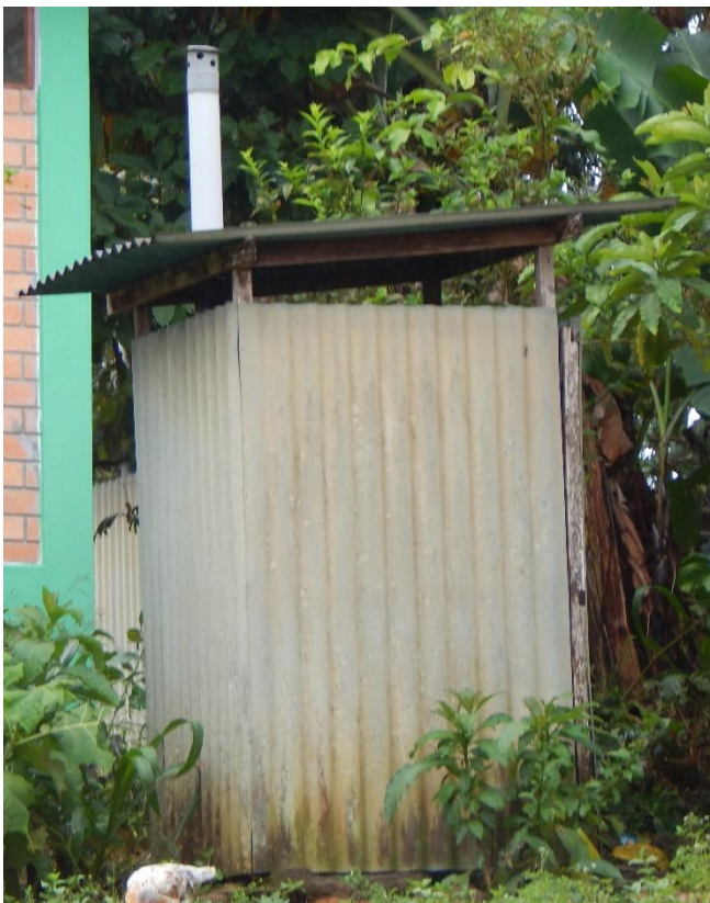
Fotografía 6. Letrina de hoyo seco ventilado.
