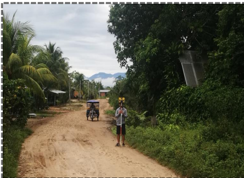
Fotografía 6: Vista del levantamiento del nivel del terreno en las diferentes calles de la Localidad de Alianza.
