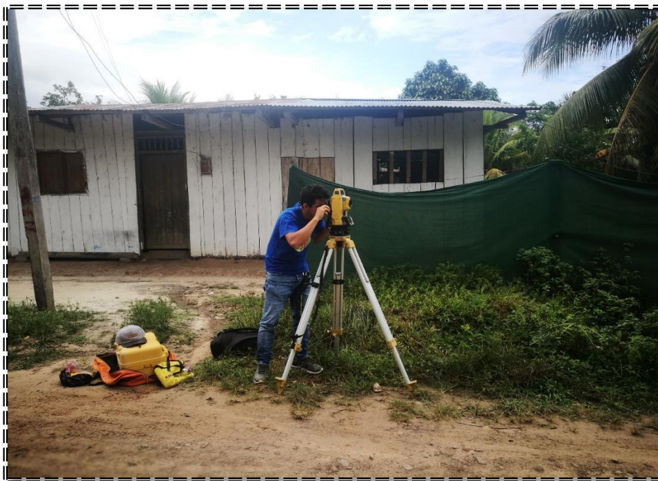
Fotografía 5: Levantamiento topográfico con estación total Topcon ES -105. El trabajo fue realizado por los 02 testistas de acuerdo a la necesidad vista en campo
