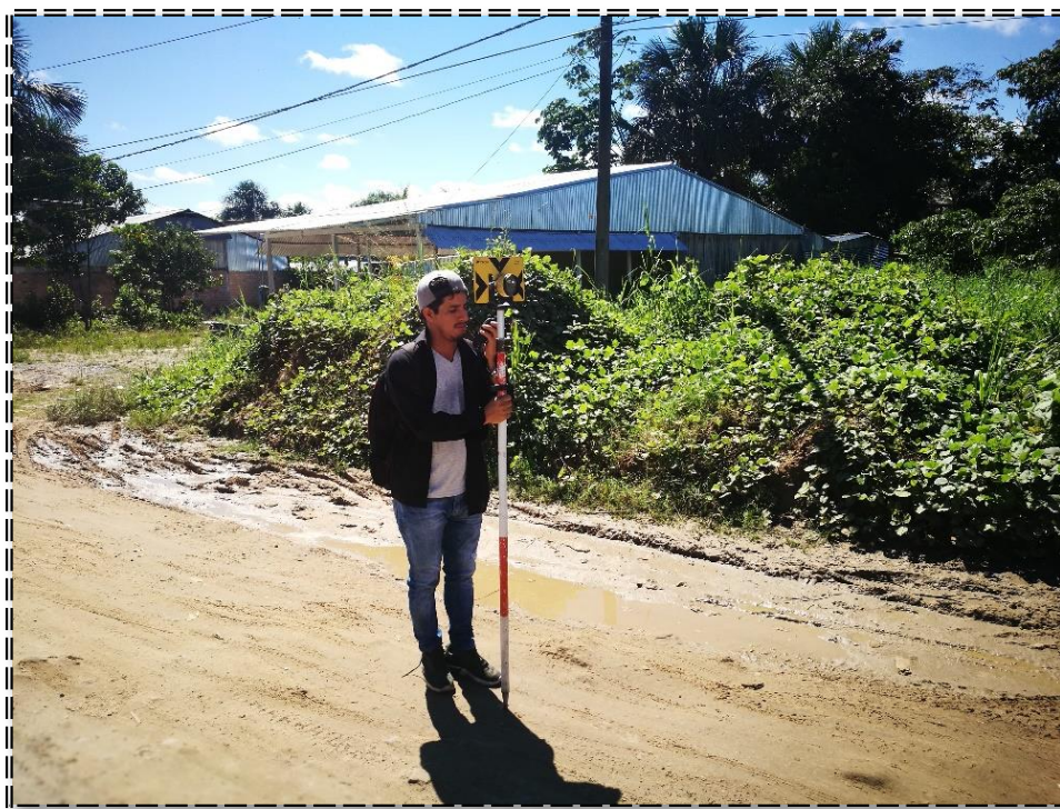
Fotografía 4: Trabajo de Campo. Levantamiento topográfico de toda el área urbana del CC. PP Alianza, estudio básico para inicio de la proyección del sistema de abastecimiento de agua potable.
