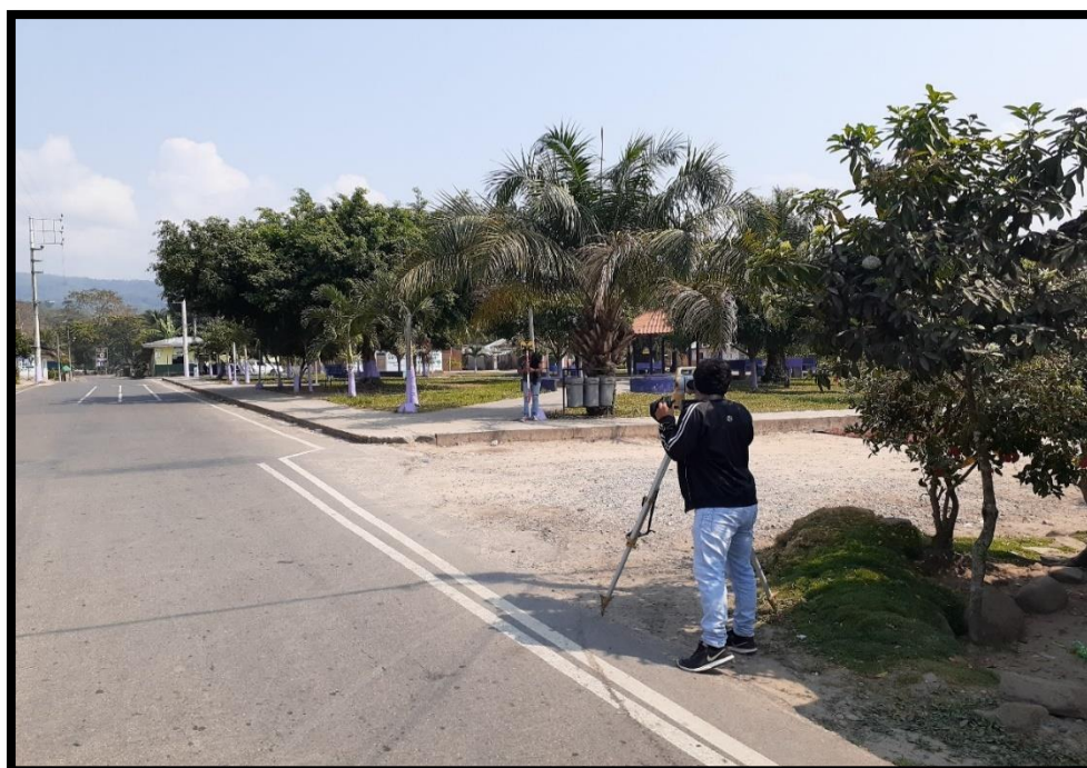
Figura 3. En la imagen se aprecia el Levantamiento topográfico realizado con estación total, para tener una perspectiva más detallada de la zona.
