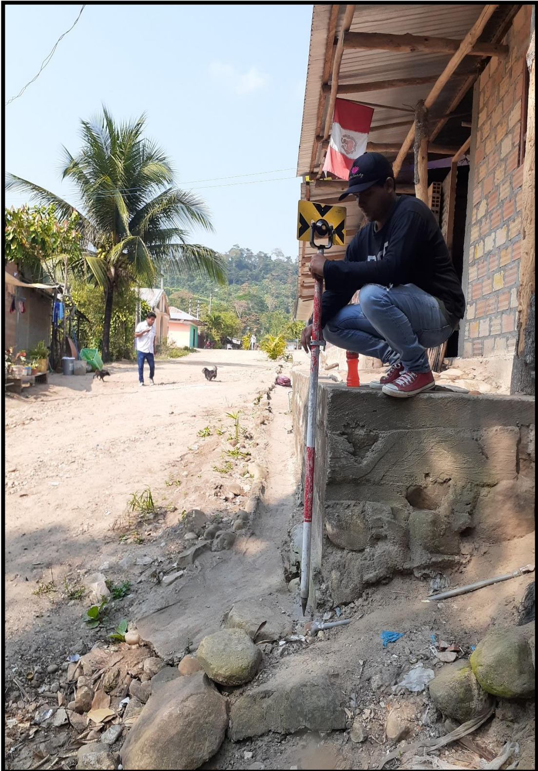
Figura 8. En la imagen se aprecia la gran diferencia de niveles entre el piso construido y las calles del centro Poblado.
