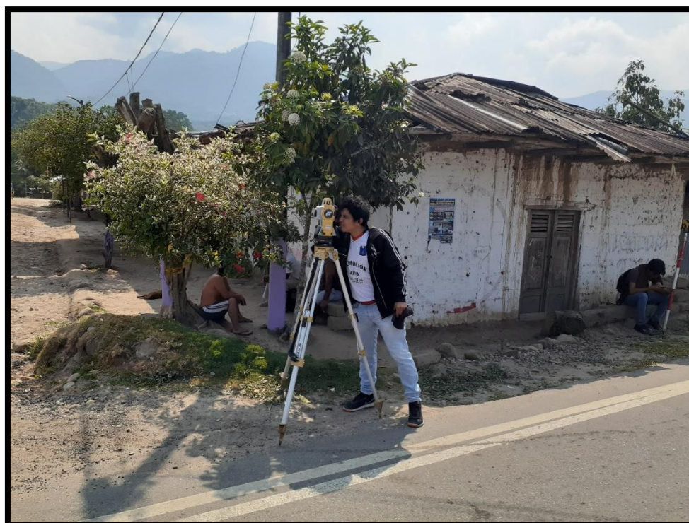
Figura 4. En la imagen se aprecia el Levantamiento topográfico realizado con estación total, en el Jirón Manco Capac.
