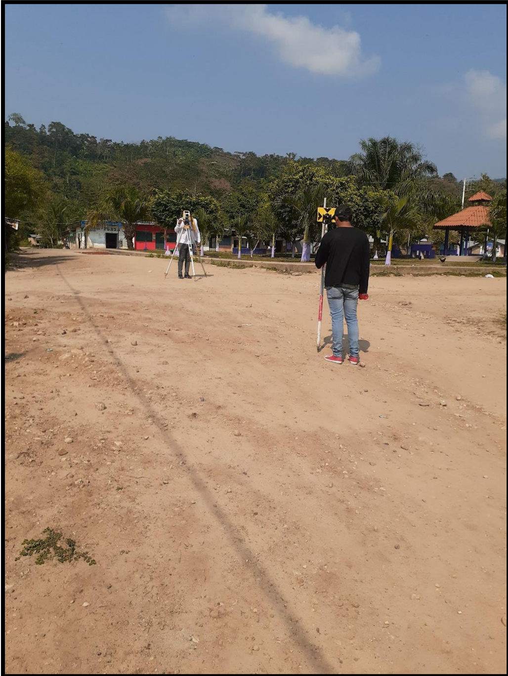
Figura 9. En la imagen se aprecia el levantamiento topográfico con estación total, para obtener datos detallados de dicho lugar, se aprecia la plaza de armas del centro poblado.
