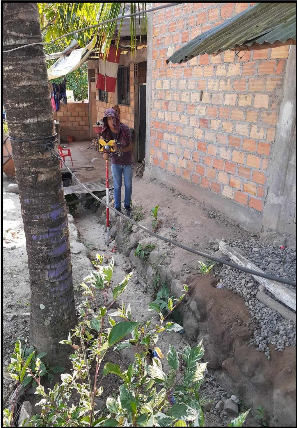
Figura 7. En la imagen se aprecia las cunetas construidos empíricamente por los pobladores de la zona.
