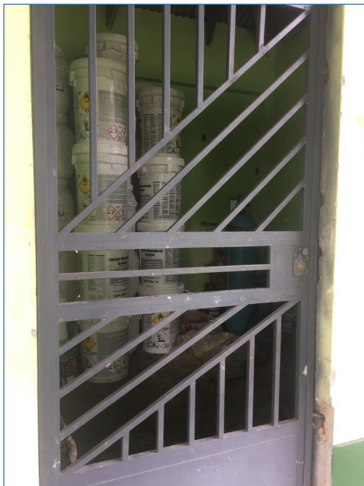
Fotografía 5. Sala de cloración
