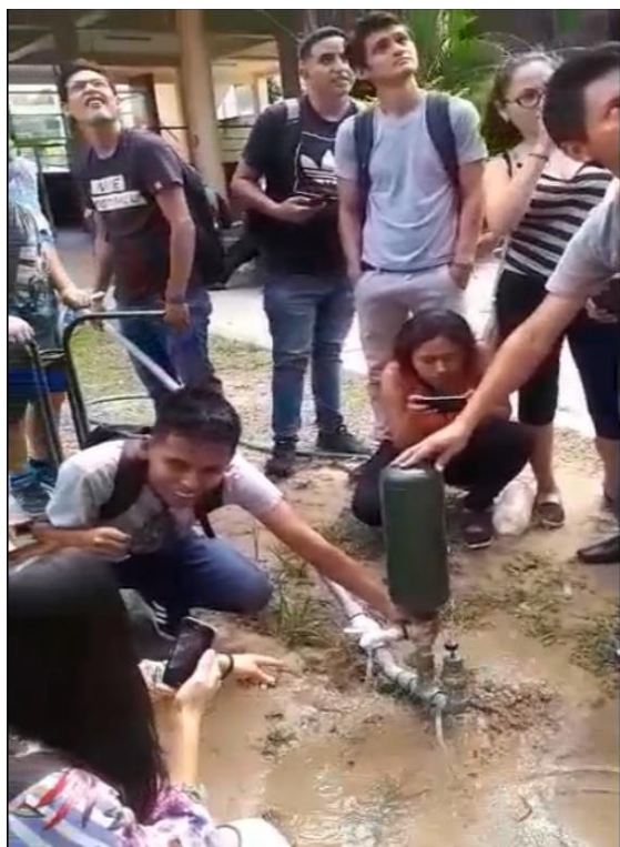
Figura 17. Instalación en el campo II. (Fuente: Elaboración propia).
