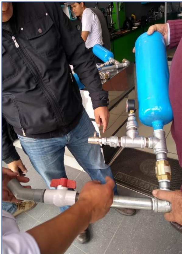
Figura 12. Construcción de la bomba de ariete II. (Fuente: Elaboración propia).
