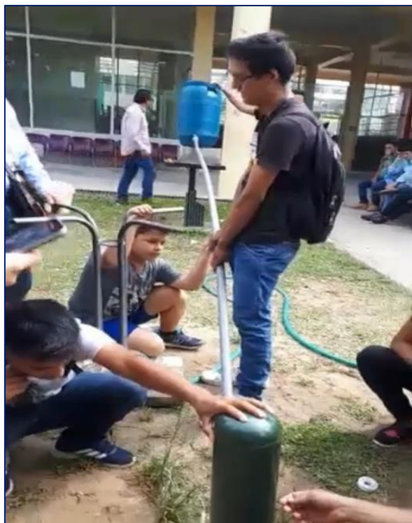
Figura 16. Instalación en el campo I. (Fuente: Elaboración propia)
