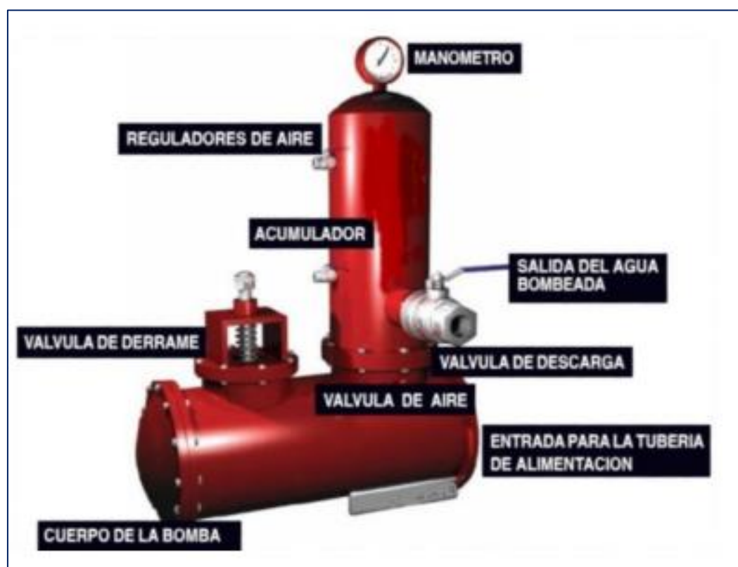
Figura 4. Bomba de ariete y sus partes. (Fuente: (Ortega, J. 2013))
