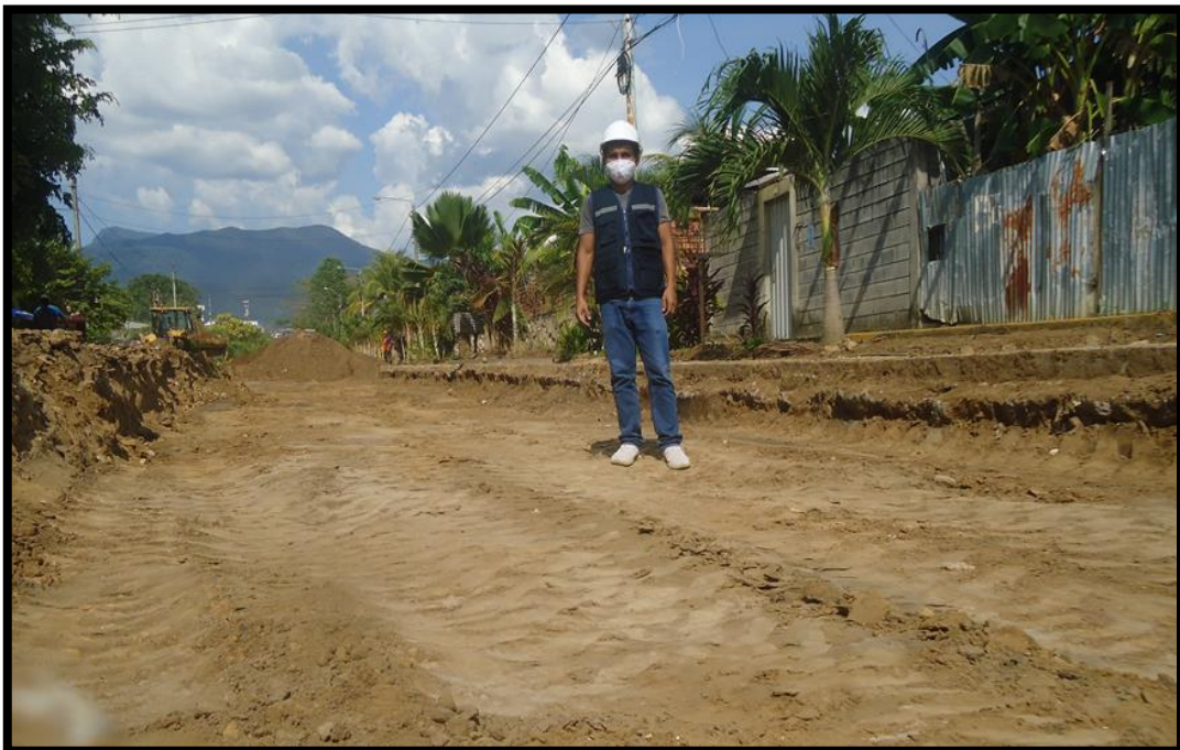
Figura 12: En la figura se observa el corte de terreno natural.
