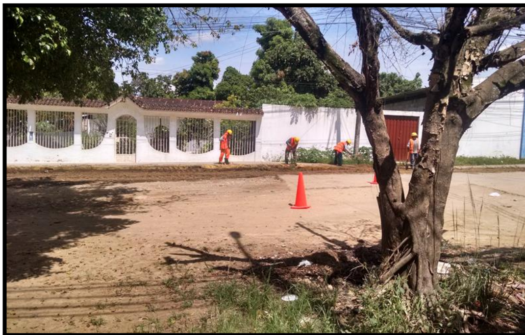
Figura 9: En la figura se observa la limpieza manual de terreno normal
