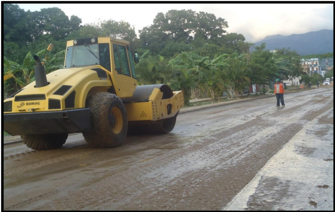
Figura 22: En la figura se muestra la compactación de material granular rodillo vibratorio de la partida “Sub- base granular”
