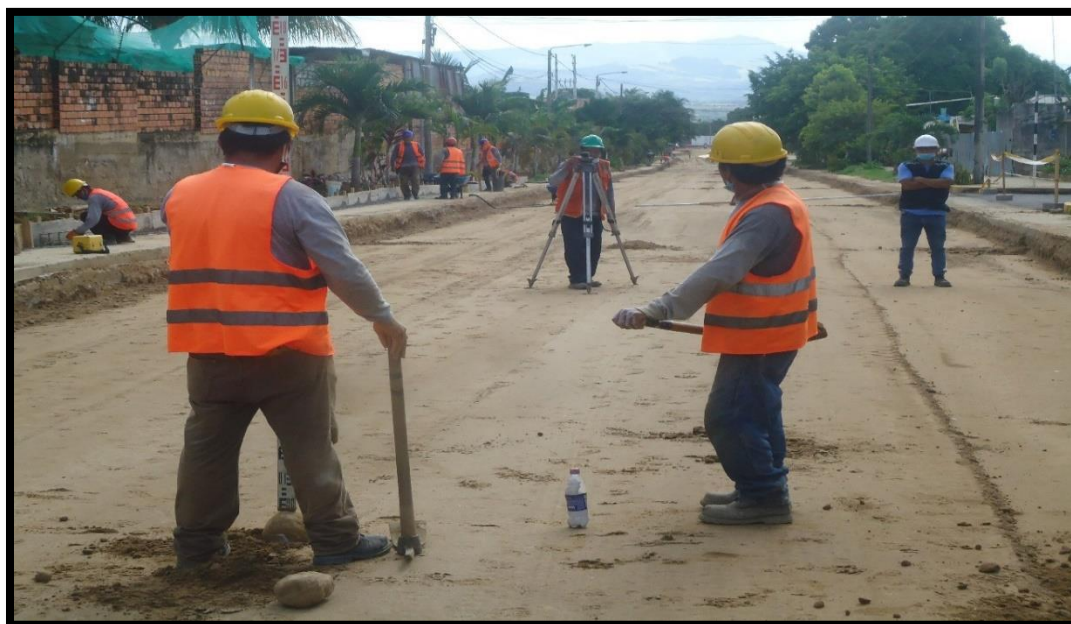
Figura 10: En la figura se observa la partida del trazo, nivelación y replanteo topográfico, para ubicar las cotas respectivas del mejoramiento con material de préstamo.
