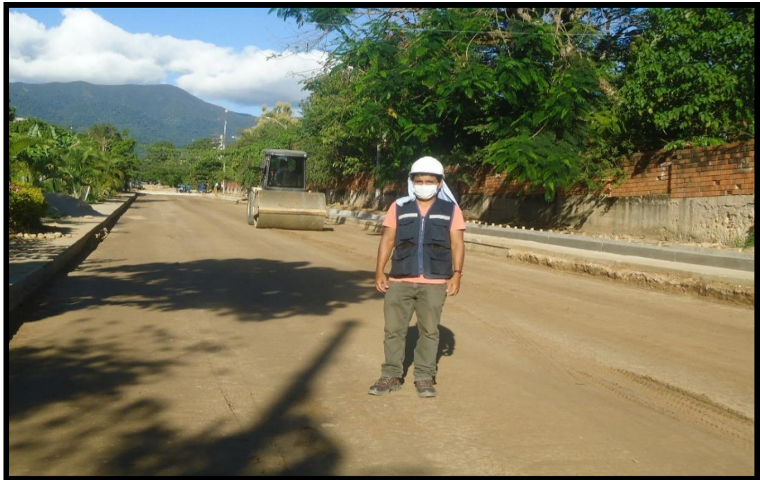
Figura 17: En la figura se observa la compactación de material con rodillo compactador vibratorio.
