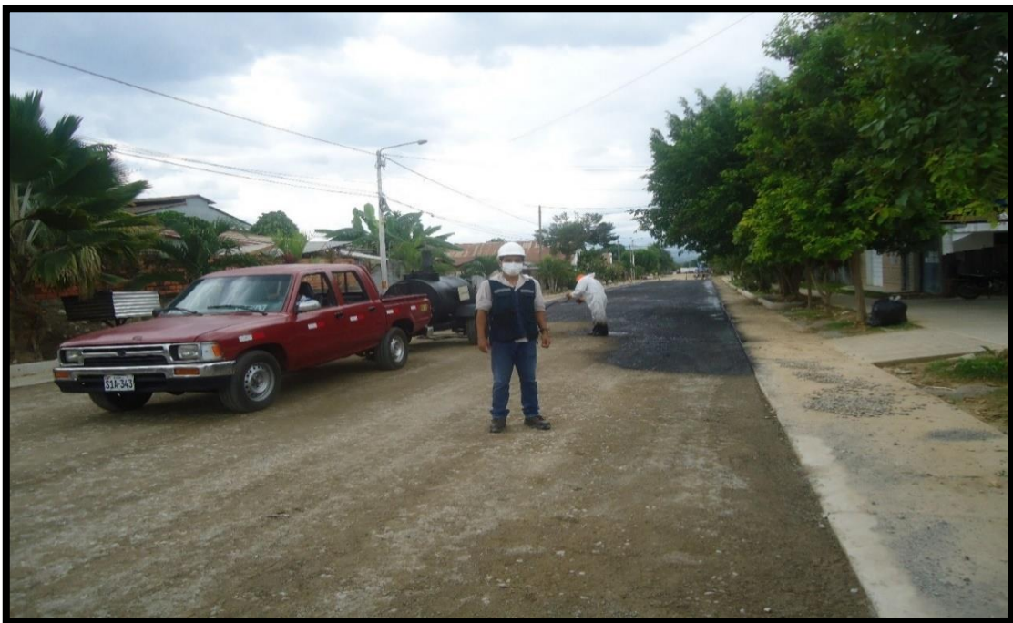
Figura 28: En la figura se observa la imprimación de la base granular.
