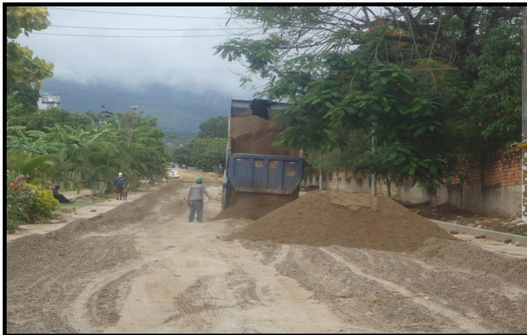
Figura 19: En la figura se muestra la colocación de material granular de la partida “Sub- base granular”
