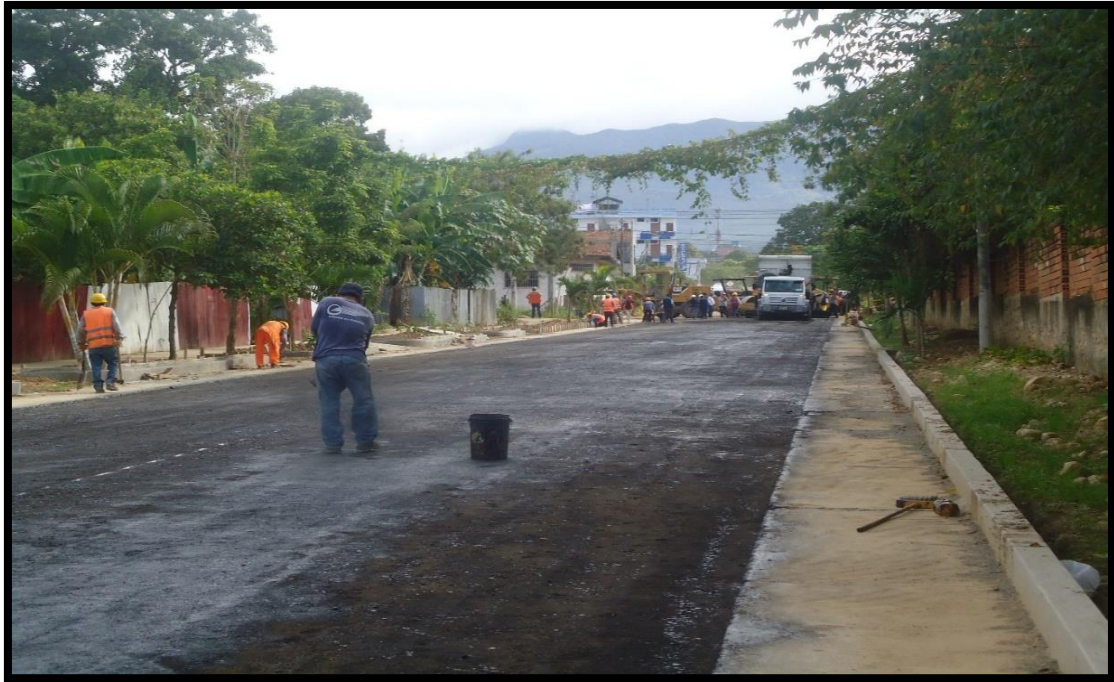
Figura 29: En la imagen se observa el esparcido de emulsión asfáltica para mejor adherencia con la carpeta asfáltica.
