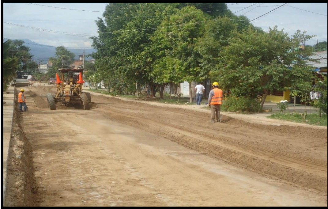
Figura 15: En la figura se observa el esparcido de material de préstamo con motoniveladora, partida de mejoramiento de subrasante e=0.20\text{m} .
