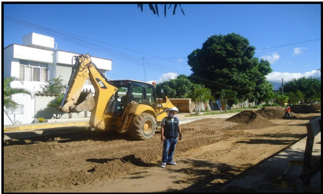
Figura 14: En la figura se observa el esparcido de material de la partida del mejoramiento de subrasante e=0.20\text{m} . con material de préstamo.
