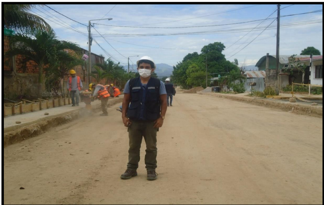
Figura 18: En la figura se observa la compactación de bordes con apisonador manual honda, de la partida: “mejoramiento de subrasante e=0.20\text{m} .con material de préstamo”
