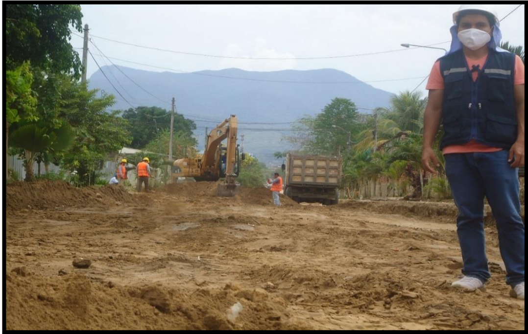
Figura 13: En la figura se observa la partida de eliminación de material excedente con transporte.
