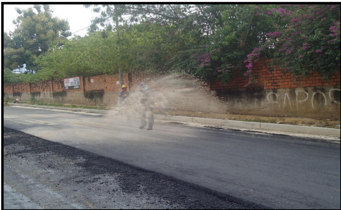
Figura 32: En la figura se muestra el esparcido manual de arena fina como sellador asfáltico.
