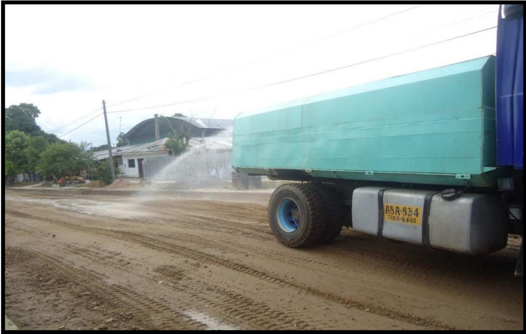
Figura 21: En la figura se muestra el riego de material granular con cisterna de la partida “Sub- base granular”
