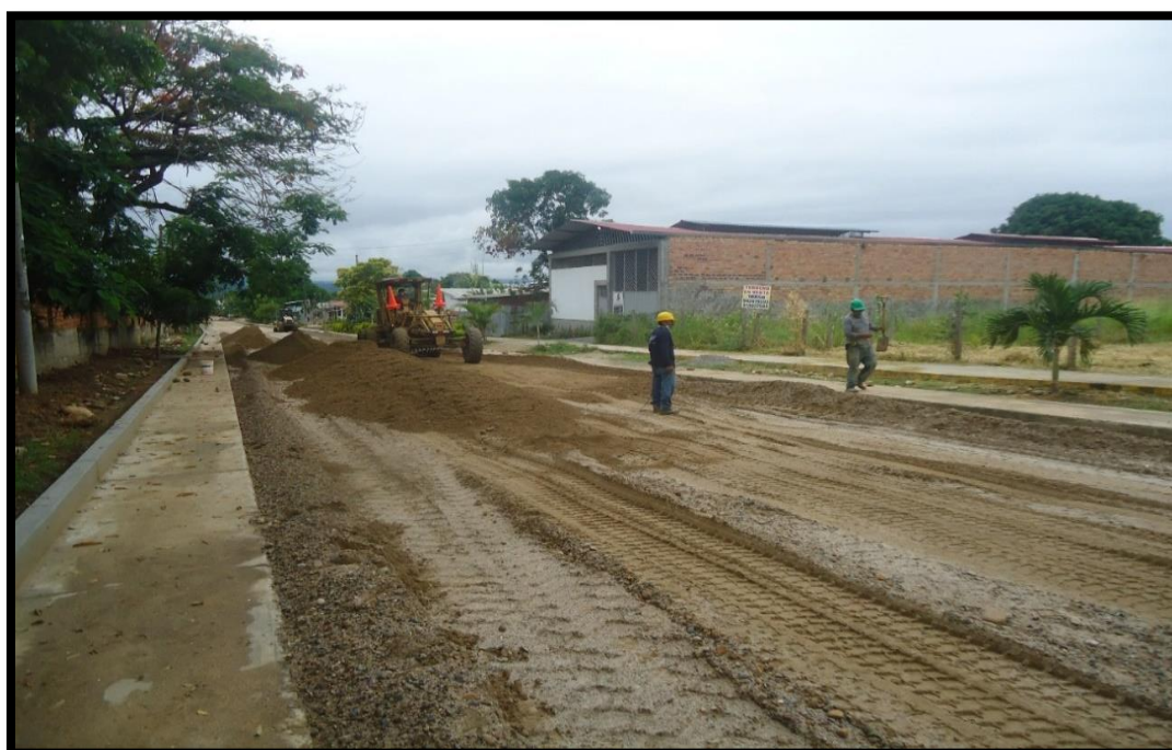
Figura 20: En la figura se muestra el esparcido de material granular con motoniveladora de la partida “Sub- base granular”
