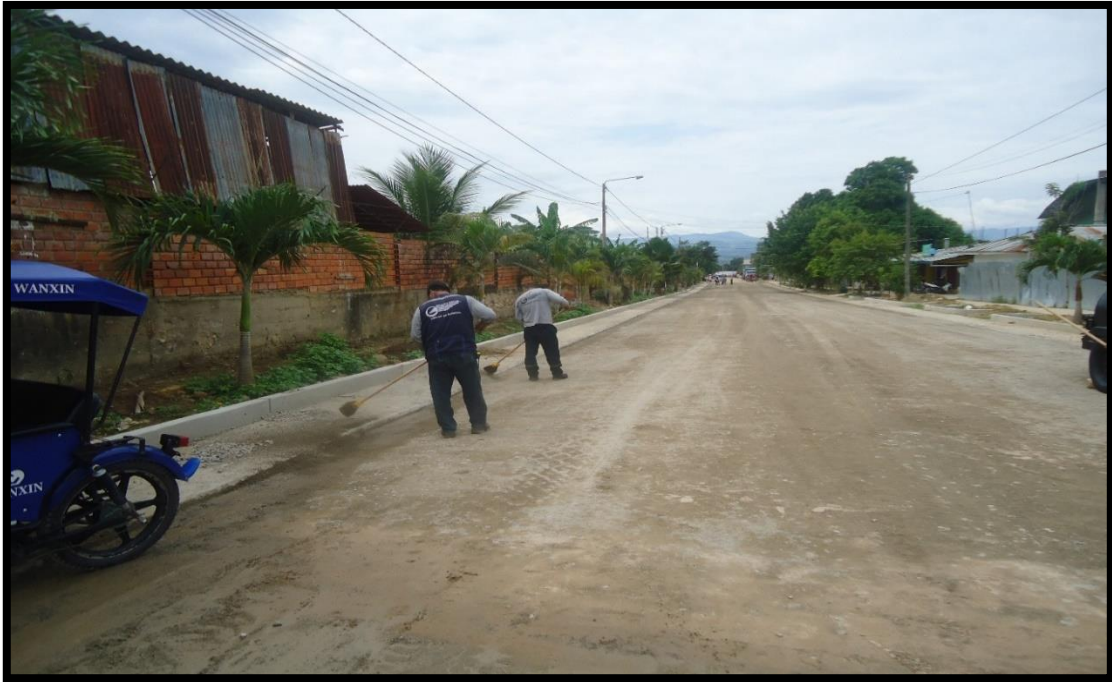
Figura 27: En la figura se observa la limpieza de la base granular para la partida de “imprimación”
