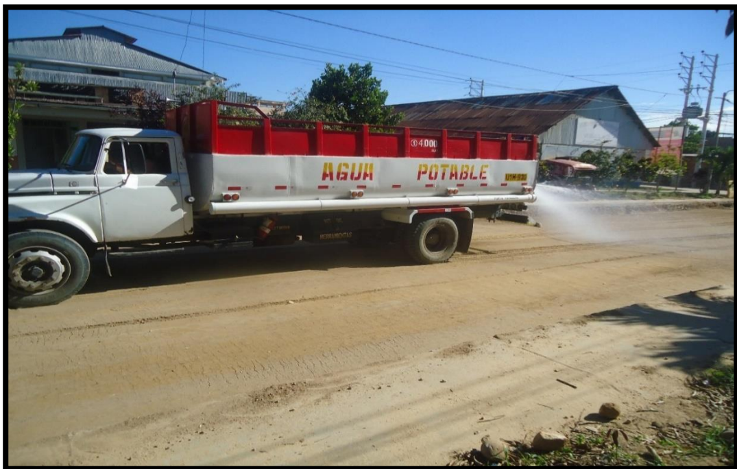
Figura 16: En la figura se observa el riego de material con cisterna.
