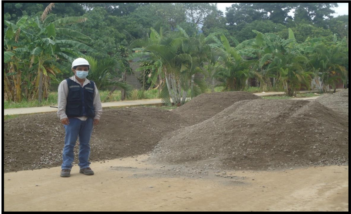
Figura 23: En la figura se muestra el material granular de la partida “Base granular”
