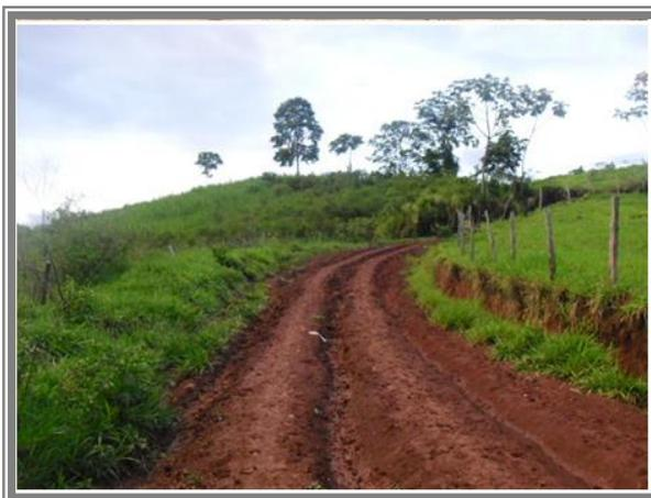
Se aprecia el tramo con ahuellamientos generados por los vehículos que se trasladan en épocas de lluvia.
