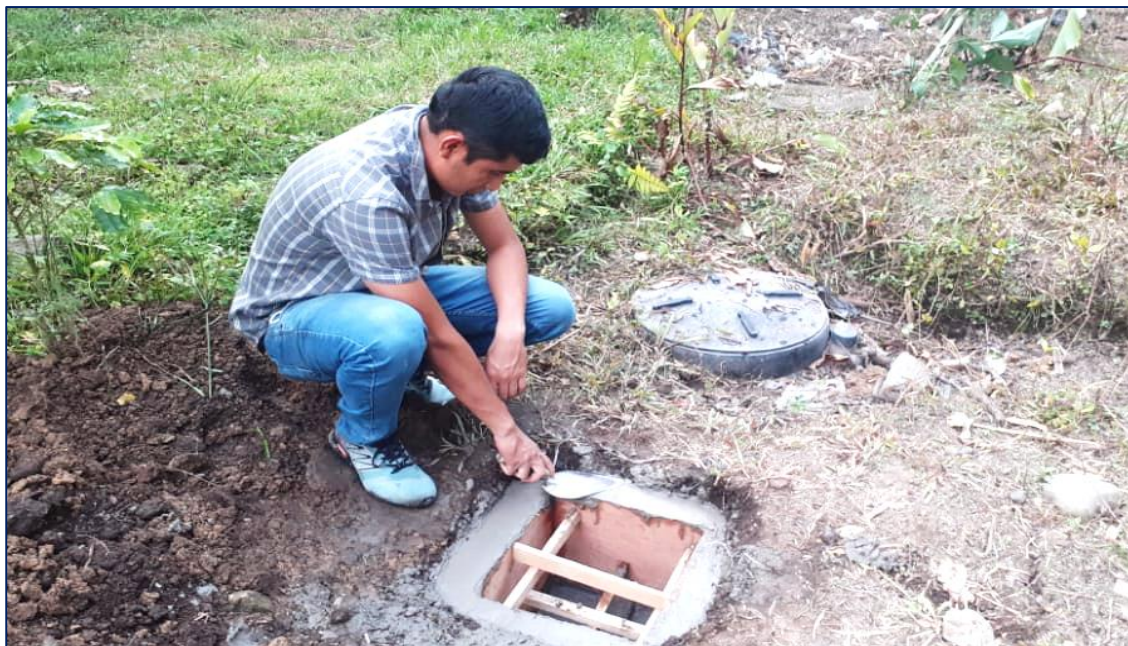
Fotografía 1: Haciendo caja de registro de salida de biodigestor, para recolección de muestras de agua.
