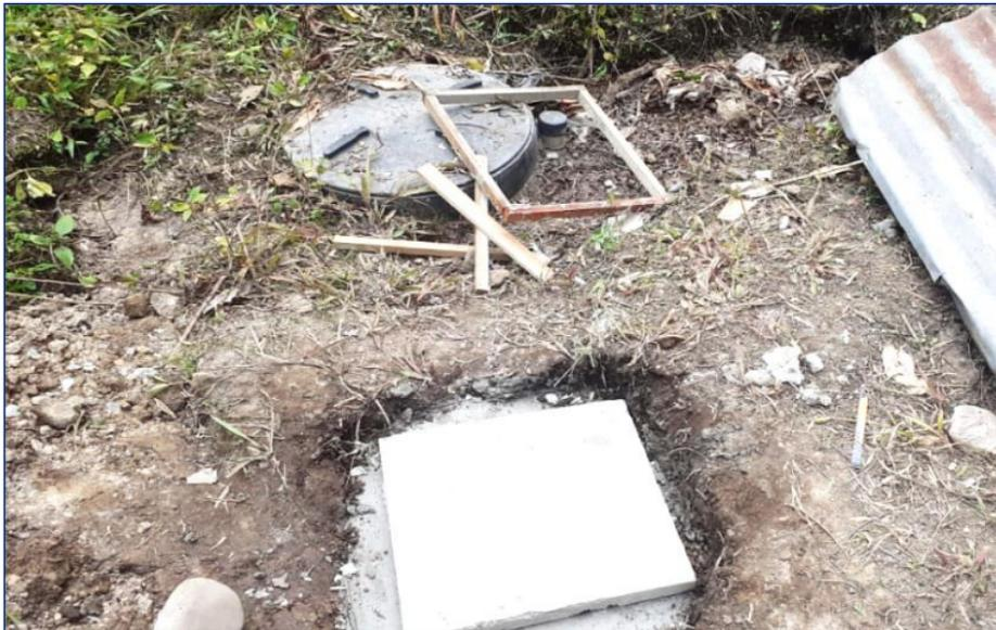
**Fotografía 2:** Caja de registro de salida de biodigestor, para recolección de muestras de agua tratada.
