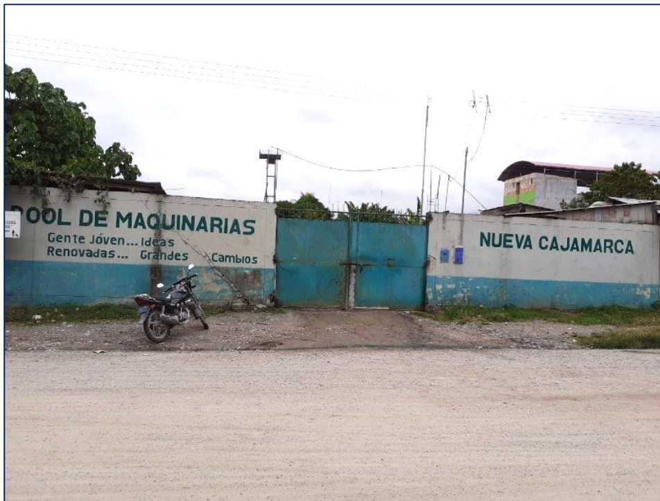
Fotografía 1. Pool de maquinarias
