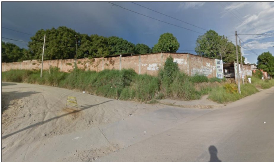
Figura 37: Vista de la intersección de los Jr. Putumayo Cdra. 02 y Av. Circunvalación Cdra. 13.
