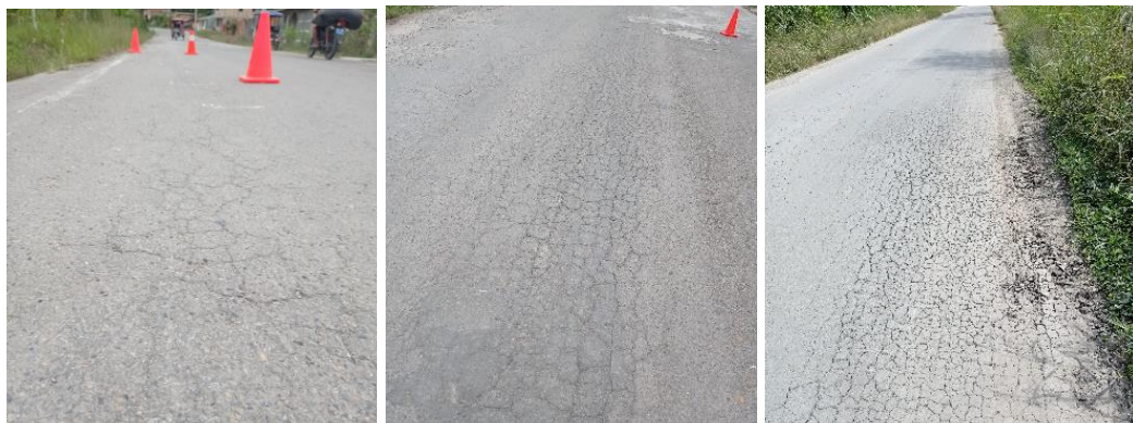
Figura 10. Foto de Falla que más predomina en la ruta: Piel de cocodrilo es sus diferentes severidades L, M, H.
