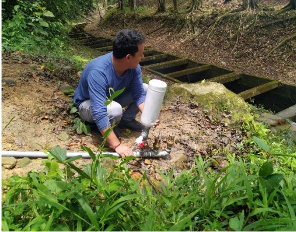
Fotografía N° 05: Instalación de la bomba de ariete.
