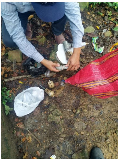
Fotografía N° 01: La implementación de la bomba de ariete.
