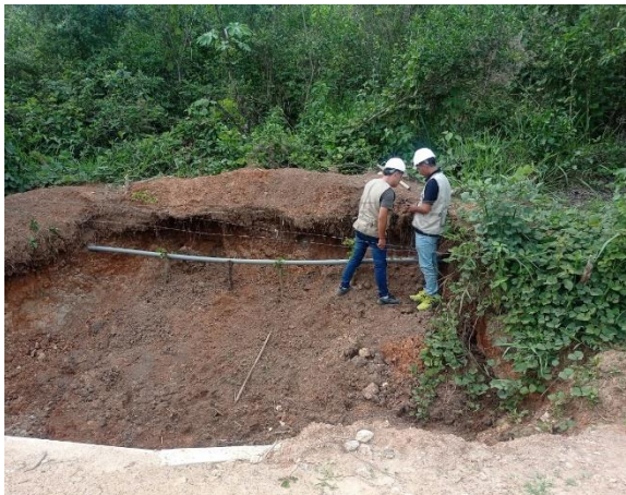
Fotografía N° 06: Verificación de las coordenadas UTM de la tubería actual.
