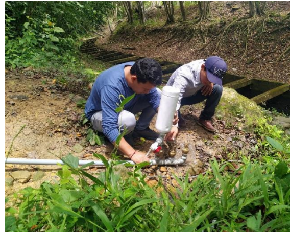
Fotografía N° 06: Instalación de la bomba de ariete.
