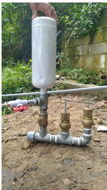
Fotografía N° 03: Culminación de la unión de la bomba de ariete
