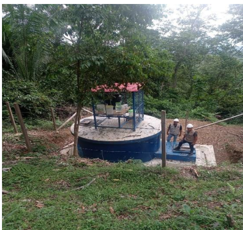
Fotografía N° 07: Reservorio circular actual de la red de abastecimiento.
