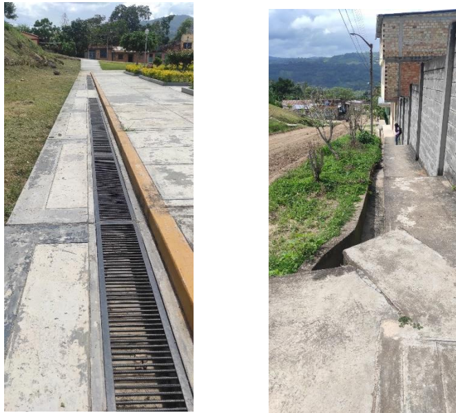
Figura 20 : Se observan algunas cunetas ya construidas, C.P. "Jerillo".
