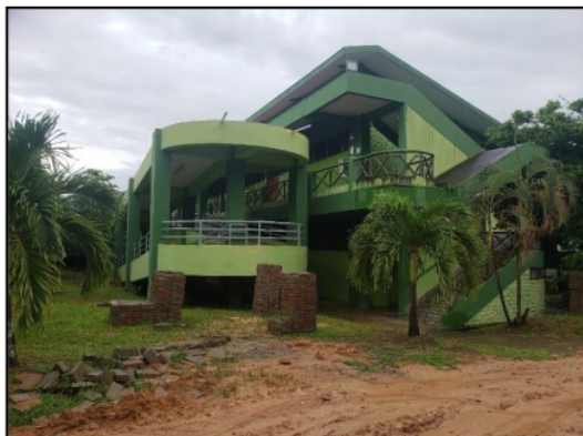
Foto N° 01: Pabellón de Aulas de la Facultad de Ciencias Agrarias (Fuente: Elaboración propia)
