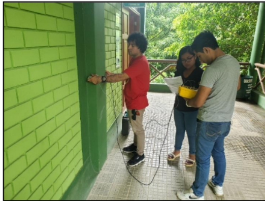
Foto N° 23: Realizando el ensayo de ultrasonido con el equipo electrónico en las columnas del Pabellón de Aulas de la Facultad de Ciencias Agrarias (Fuente: Elaboración propia)
