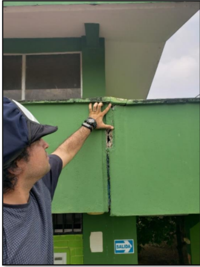
Foto N° 13: Presencia de fisuras entre las juntas en las vigas del segundo nivel del Pabellón de Aulas de la Facultad de Ciencias Agrarias (Fuente: Elaboración propia)
