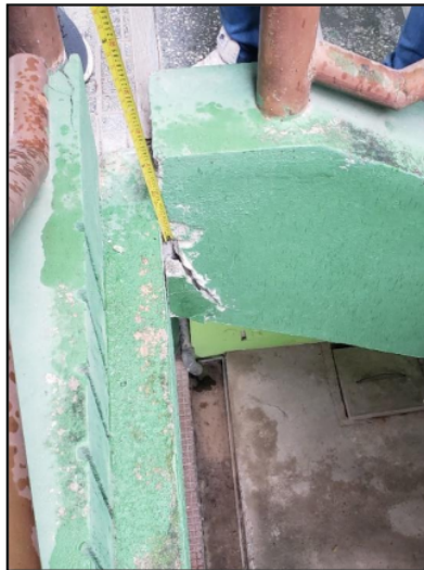
Foto N° 17: Presencia de fisuras y desprendimiento del concreto de la escalera de acceso por falta de junta sísmica en el Pabellón de Laboratorios y Gabinetes de la Facultad de Ciencias Agrarias (Fuente: Elaboración propia)
