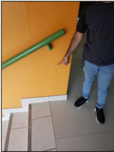
Foto N° 13: Presencia de fisuras entre las juntas en las vigas del segundo nivel del Pabellón de Aulas de la Facultad de Ciencias Agrarias (Fuente: Elaboración propia)
