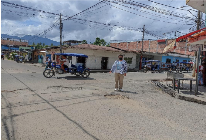
Fotografía 11: Se visualiza al tesista en la intersección de los jirones Arica y Alfonso Ugarte, identificando las fallas de baches.
