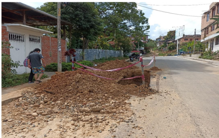
Fotografía 9: Se visualiza la reparación de la red de desagüe en el Jr. 1 de Mayo Cuadra – 1. En muchas ocasiones al finalizar las reparaciones, no existe una buena recuperación de las capas de pavimento (Base y Sub base). Que al pasar el tiempo se convertirá en una falla de bache.
