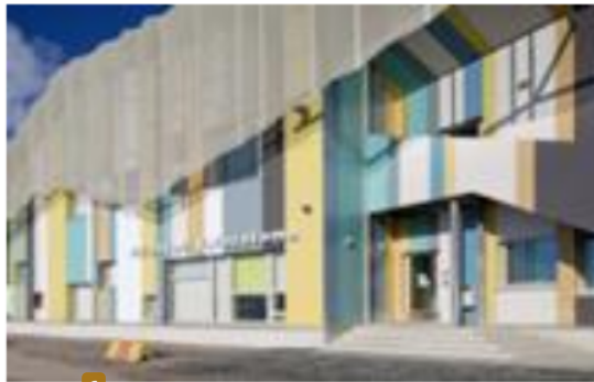
Figura 16 Fachada principal de la Escuela Kalasatama, Finlandia
