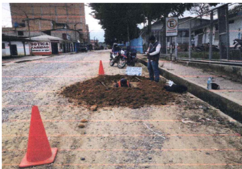
Figura 19. Excavación de la calicata N° 01, en el Jr. Pajaten C-03 del Distrito de la Banda de Shilcayo.
