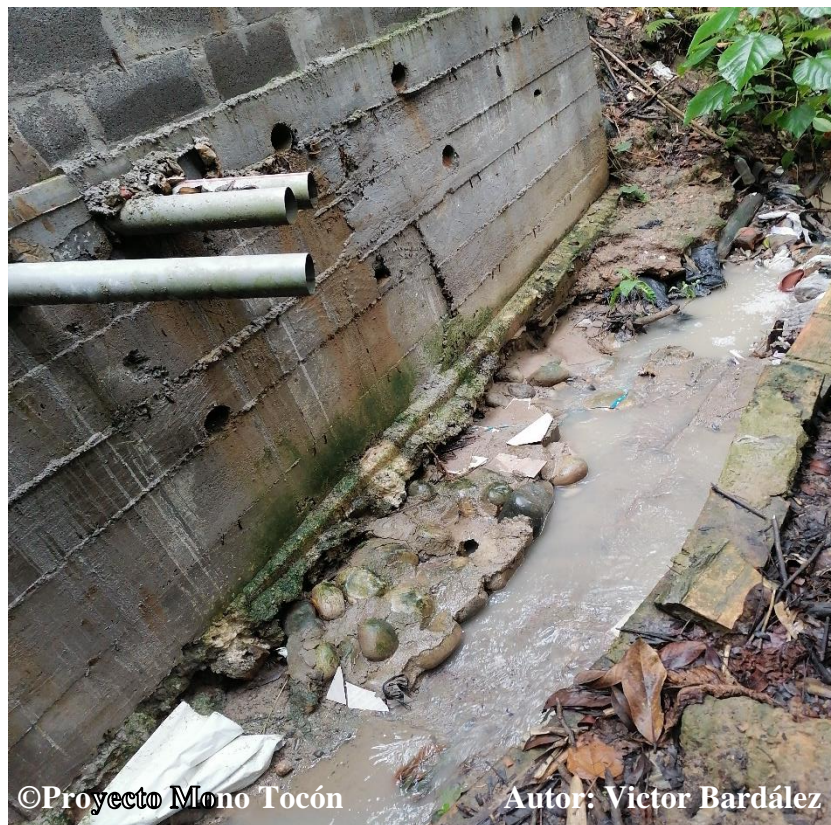
Fotografía 10. Instalación de efluentes de aguas residuales en los barrancos
