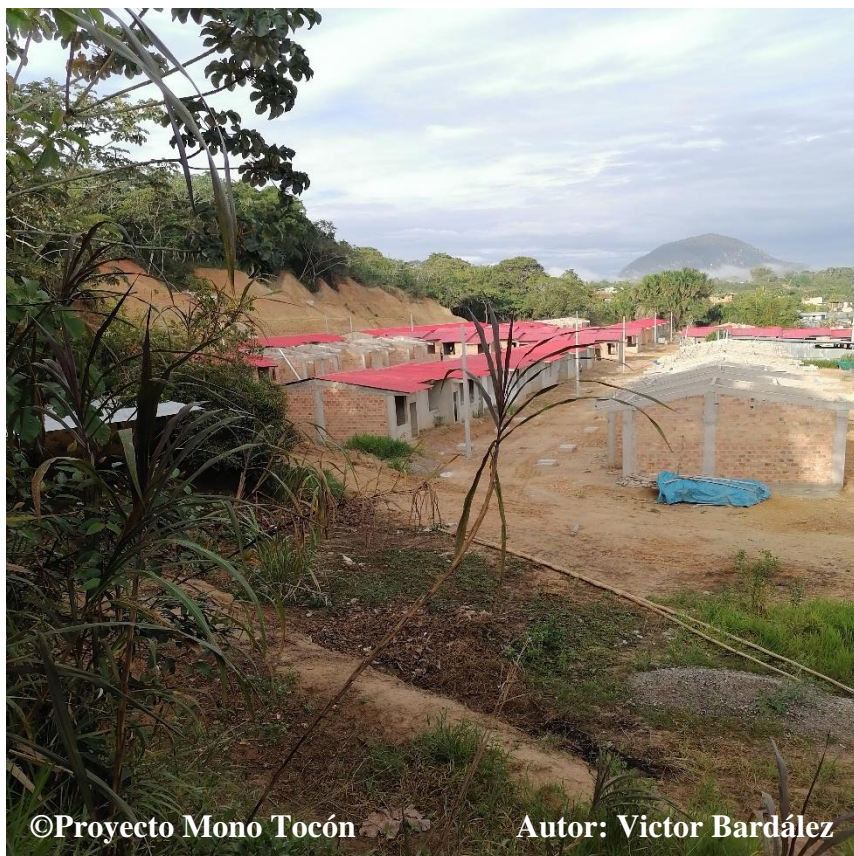
Fotografía 11. Cambio de uso de suelo en los barrancos para construcciones
