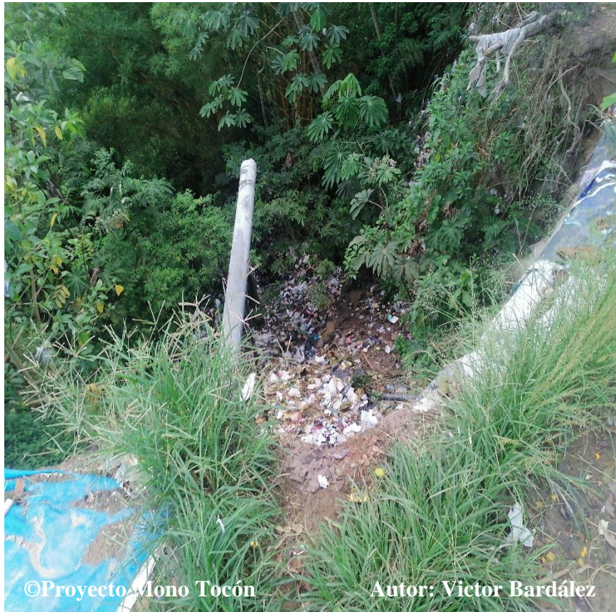
Fotografía 9. Barranco con efluente de aguas residuales y botadero
