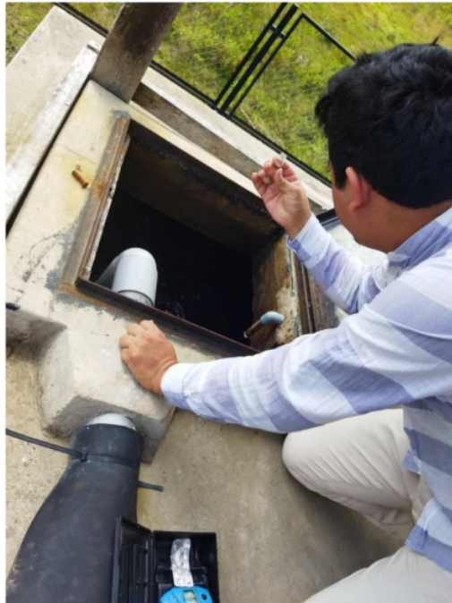
Fotografía 6. Muestreo de cloro en el reservorio.
