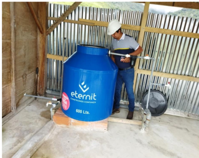
Fotografía 1. Recorrido de reconocimiento del reservorio del sistema de agua potable de Marona.
