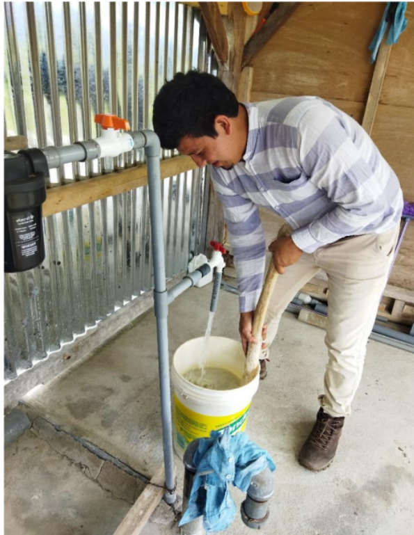
Fotografía 3. Preparación del cloro para vertimiento al Reservorio.
