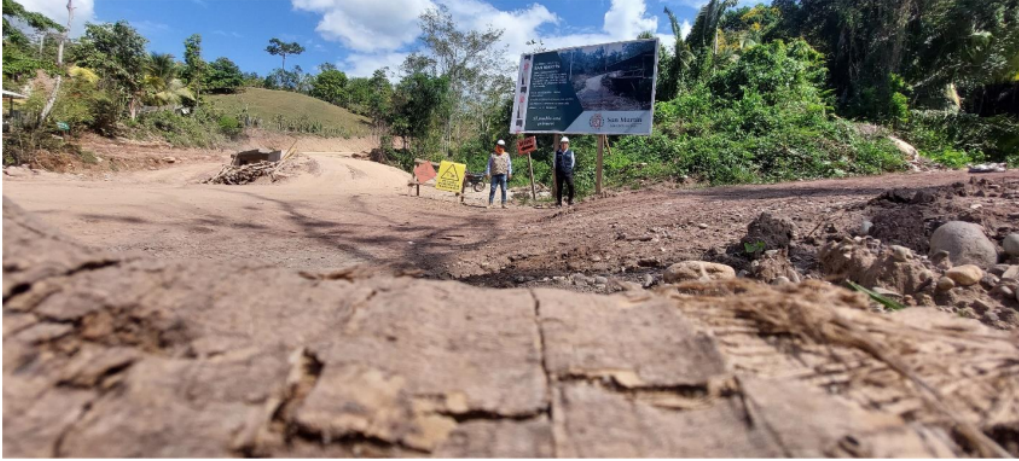
Foto N°1. Se observa el cartel de obra el cual se encuentra en la progresiva 0+020.00 del tramo del proyecto en estudio.
