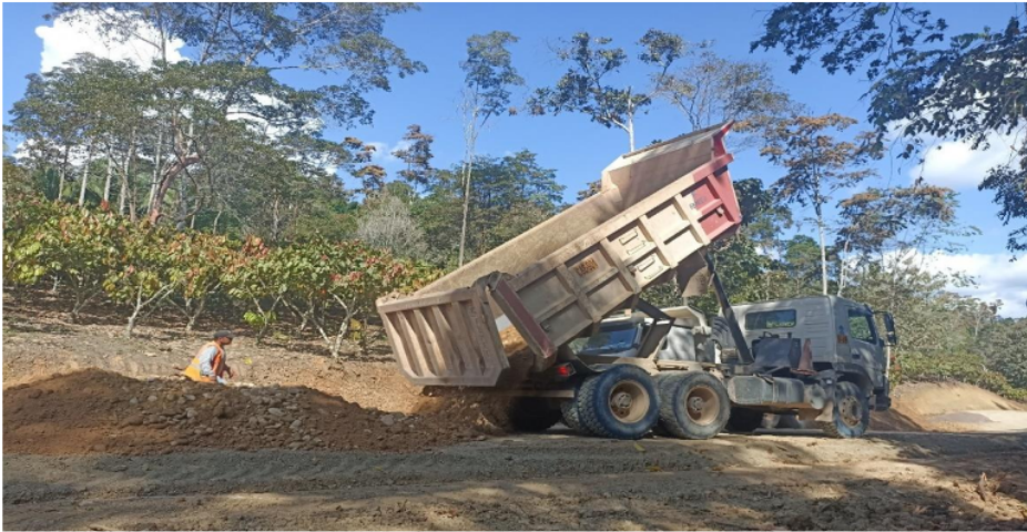
Foto N°5. Se observa al volquete dejando cada 15 metros el material que servirá para subbase de la carretera, corresponde a la progresiva 7+786.00
