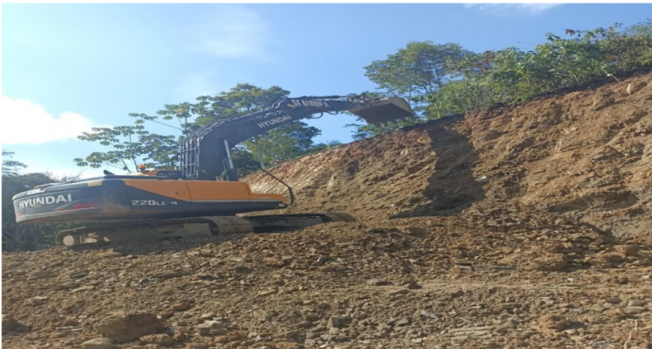
Foto N°6. Se observa a la excavadora Hyundai 220 Lc realizando el corte del talud en la progresiva 2+228.00.
