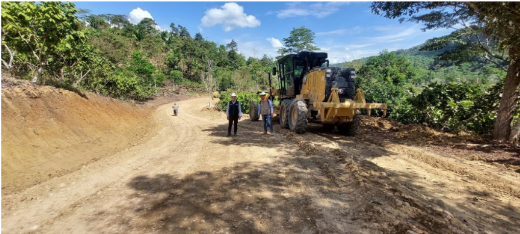
Foto N°4. Se observa a la motoniveladora realizando trabajos de regadío del material para la capa anticontaminante de 0.15 metros posterior a eso le dará una pasada el rodillo liso vibratorio, corresponde a la progresiva 7+350.00.
