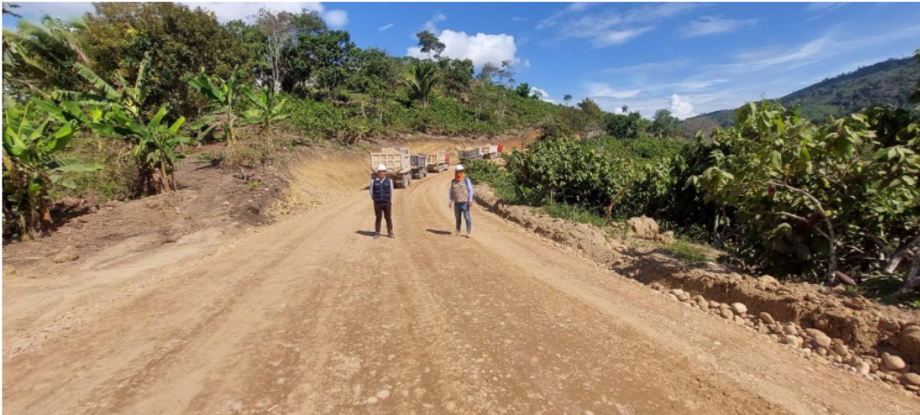
Foto N°3. Se puede apreciar a volquetes llevando material para lo que correspondería a la subbase esta fotografía fue tomada en la progresiva 6+784.00.
