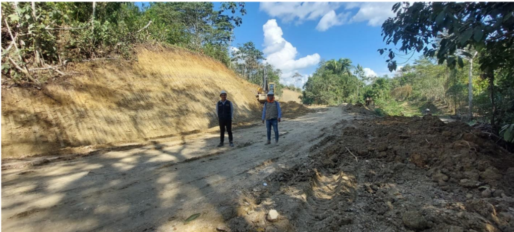
Foto N°2. Se puede observar a la excavadora realizando un corte a media ladera corresponde a la progresiva 3+258.56 de la carretera.
