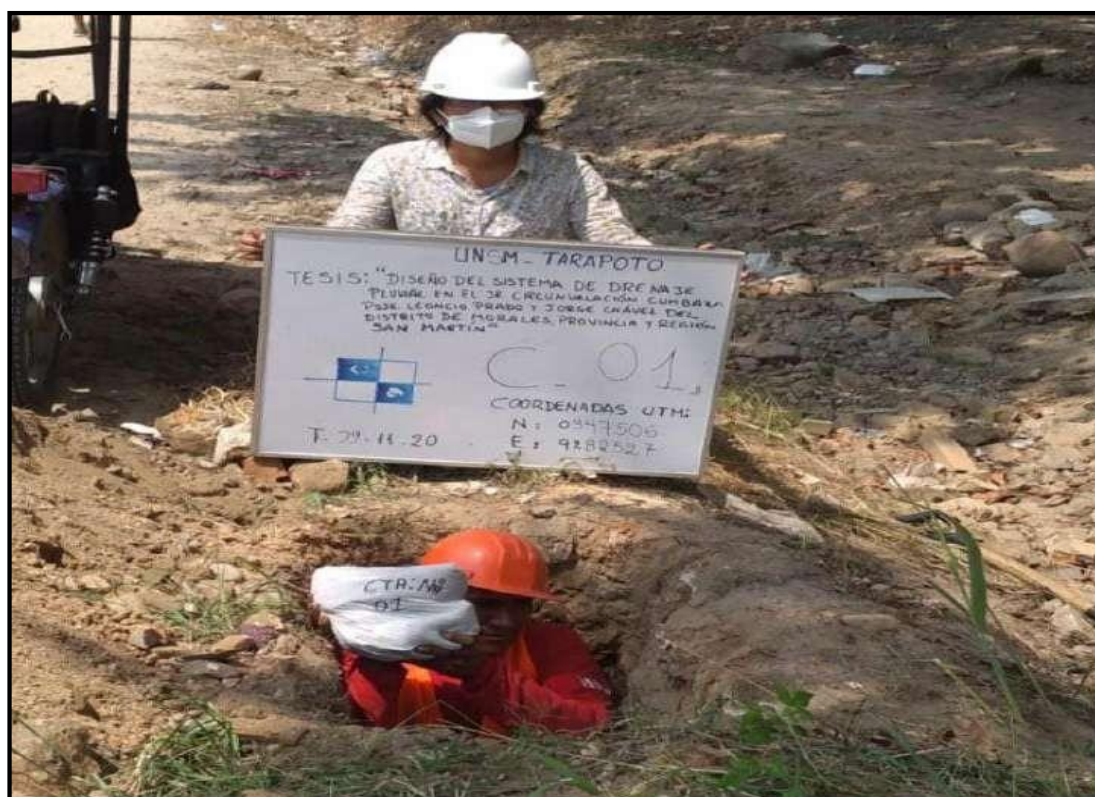
Figura 224. En la imagen se aprecia la calicata N° 1, excavada para tomar muestras, y posteriormente realizar los estudios respectivos para el diseño estructural de los colectores y cuentas. (Fuente: Elaboración propia)
