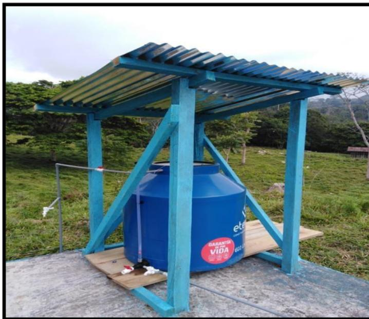
*Fotografía 2.* Montaje y puesta en marcha del sistema de cloración por goteo
