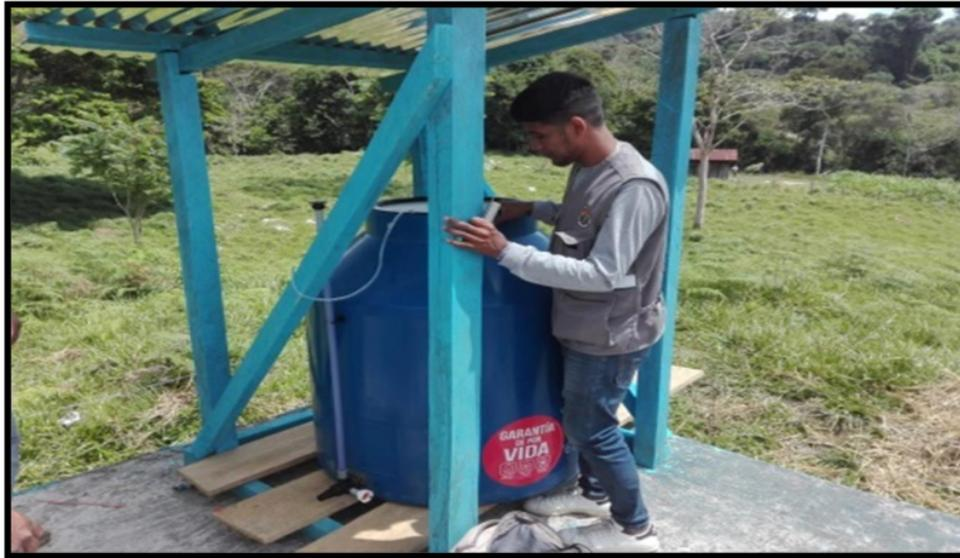
*Fotografía 1.* Instalación del sistema de cloración por goteo
