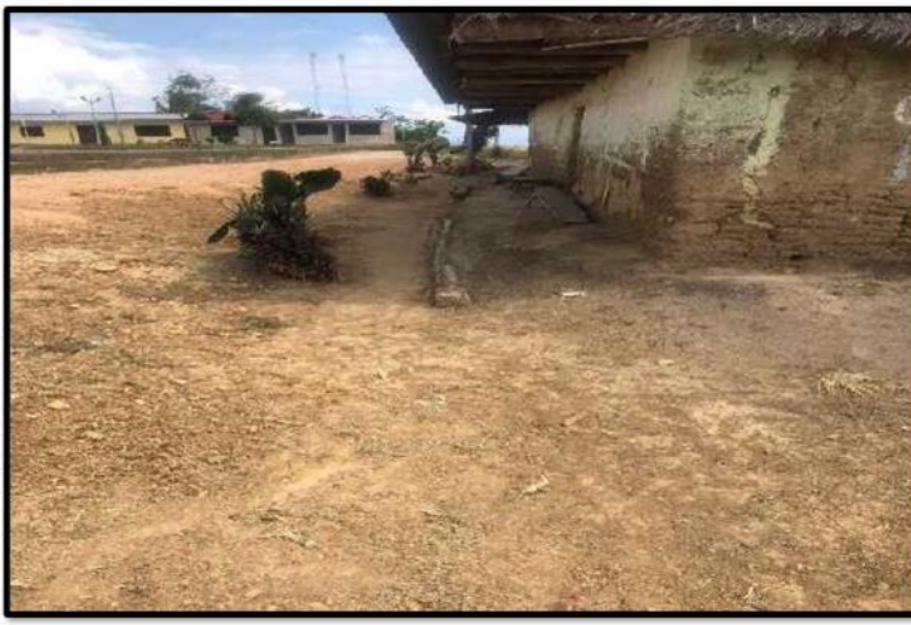
Foto 4: Se puede observar la inexistencia del sistema de drenaje pluvial en la localidad de aocaloma.
