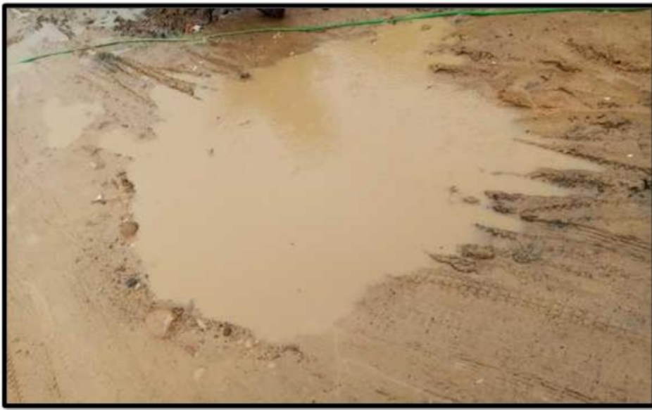
Foto 2: Se aprecia un estancamiento en las calles ya que el Sistema de Drenaje no es capaz de evacuar eficientemente el agua en el caserío de aocaloma.
