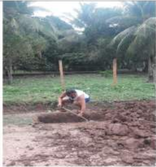
Fotografía N° 06: EXCAVACION DE MUESTRA N 16
