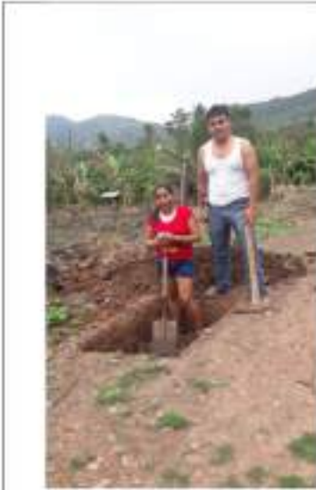
Fotografía N° 05: EXCAVACION DE MUESTRA N 15
